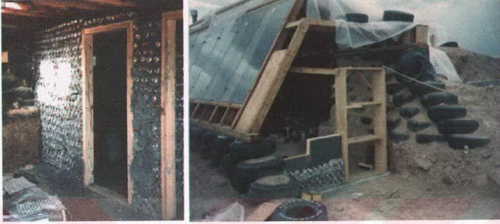
Resim 2.2 Teneke bira kutuları ve kullanılmış araba lastiklerinden yapılan bir araştırma binası
