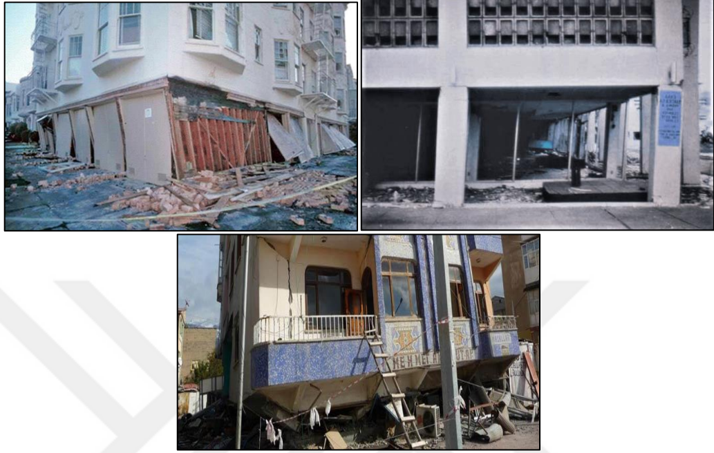
Şekil 2.5. Yumuşak kat düzensizliği sonucu yıkılan binalar
