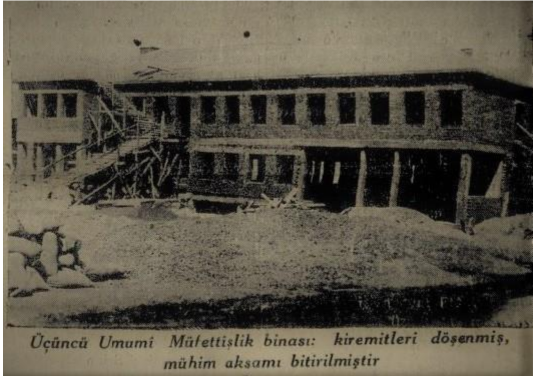
Doğu , S.226, 25 Ağustos 1938. Umumi Müfettişlik Binasının İnşaatı.
