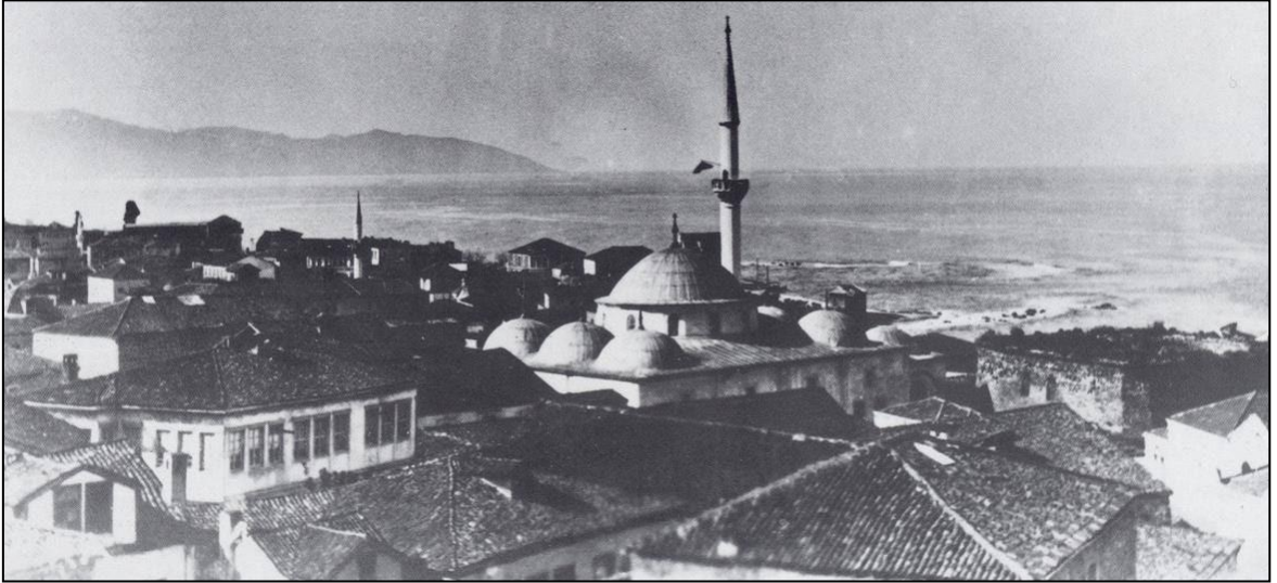
Şekil 55. Trabzon Çarşı Camii, 1945, (Bölükbaşı, 2006)
