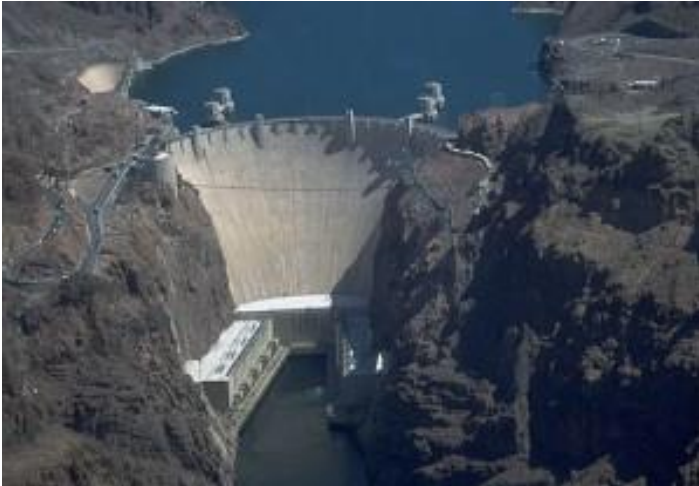
Şekil 1.5. Biriktirmeli hidroelektrik santral (URL-6, 2016)
