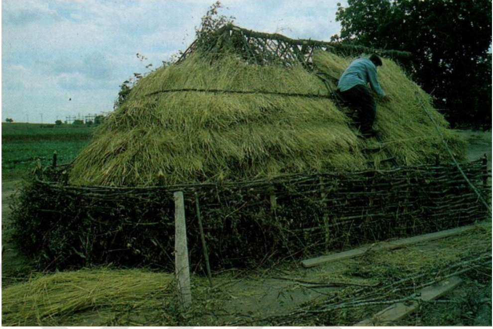
Şekil 2.8: Yapının örtüsünü oluşturmak için çavdar sapları yerleştirilirken (Karul vd. 1998: 26)
