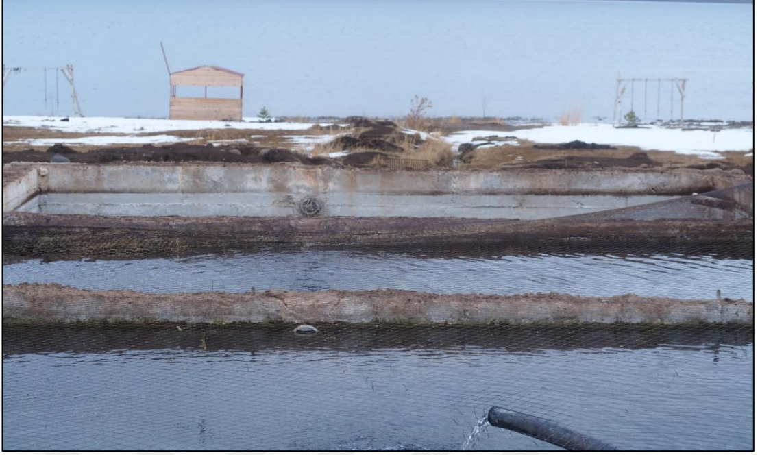
Fotoğraf 5.25: Balık Gölü Dolaylarında Alabalık Yetiştirilen Beton Havuzlardan Bir Görünüm
