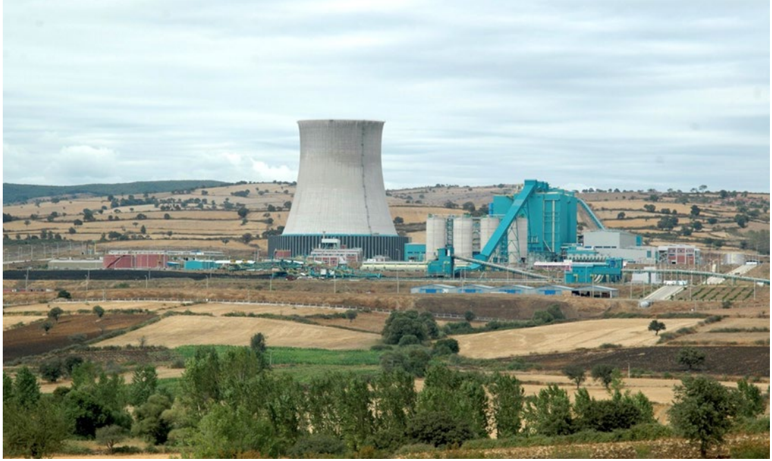
Şekil 3.1. Çan Termik Santrali (EÜAŞ 2025)
