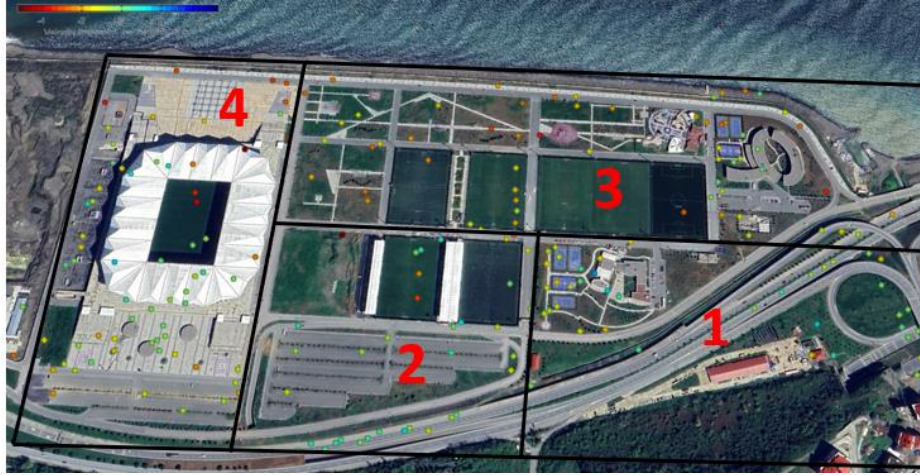
Şekil 4.7. Akyazı Stadyumu çalışma alanında belirlenen zamansal korelasyonu 0,7 ve üzerindeki PS noktalarının dağılımı ve bölgeler.
