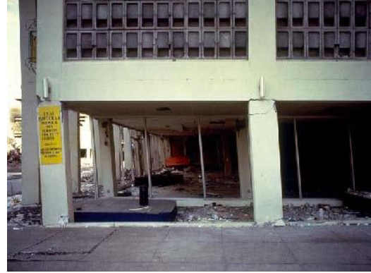
b) Yumuşak kat mekanizması
