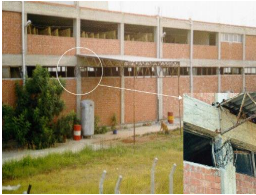
a) Kısa kolon mekanizması
