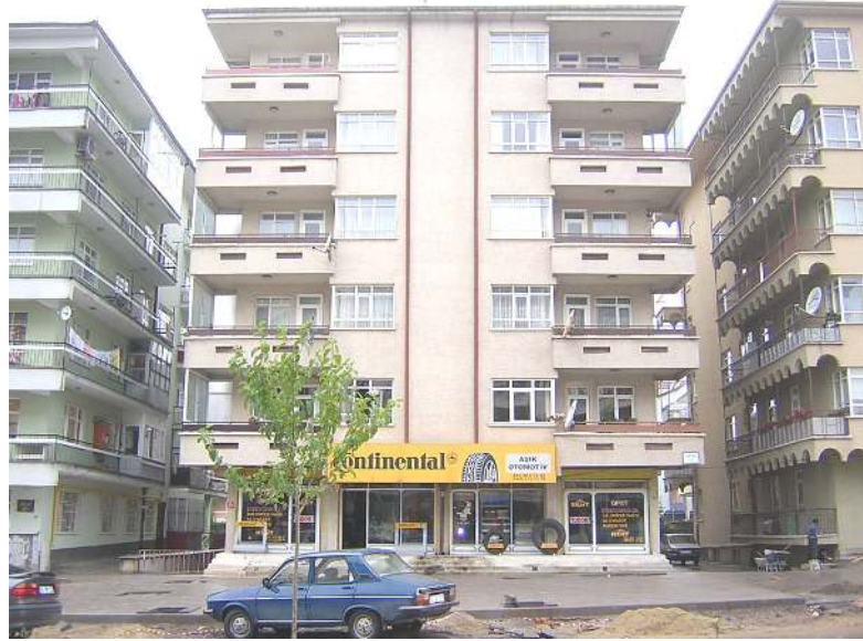
Şekil 6.9 Bilge Apt. görünüş
