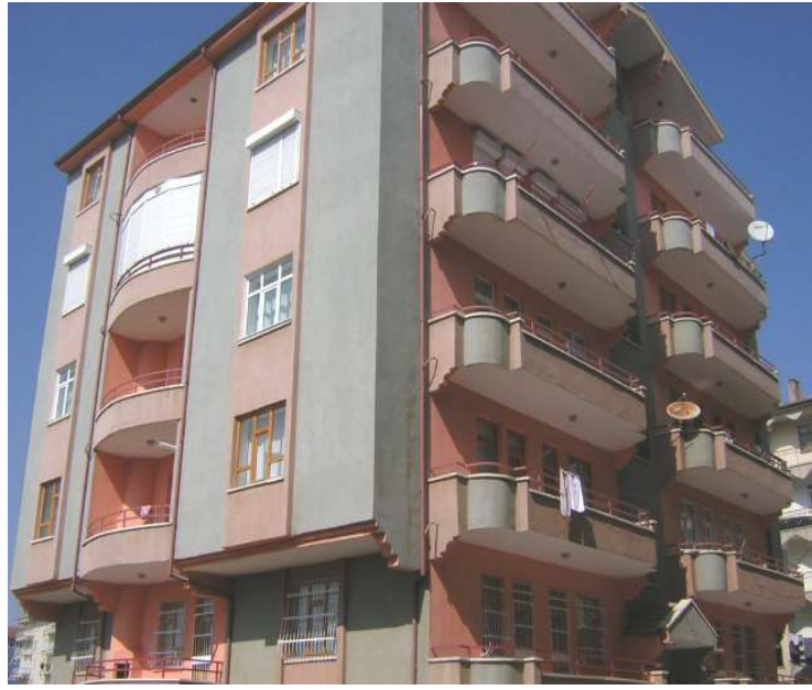
Şekil 6.49 Pembeköşk Apt. görünüş
