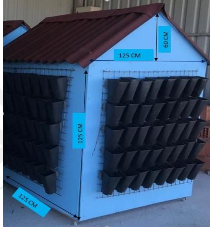
Şekil 3.10. Model binalar ve yeşil duvar sisteminin kurulumu
