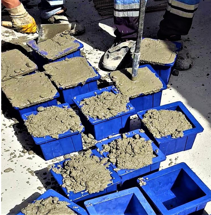
Resim 4.2 Kalıplara dökülen betona vibrasyon işleminin uygulanması
