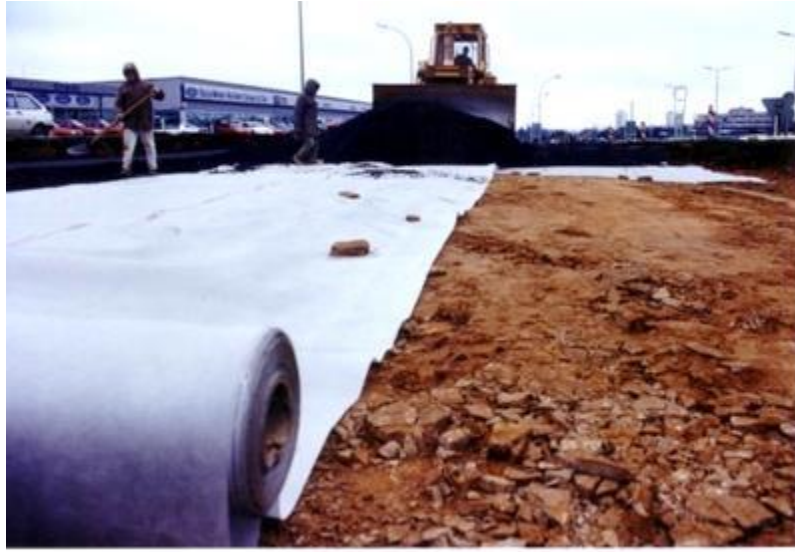
Şekil 1.33.Örgüsüz geotekstil (URL-2, 2013)
