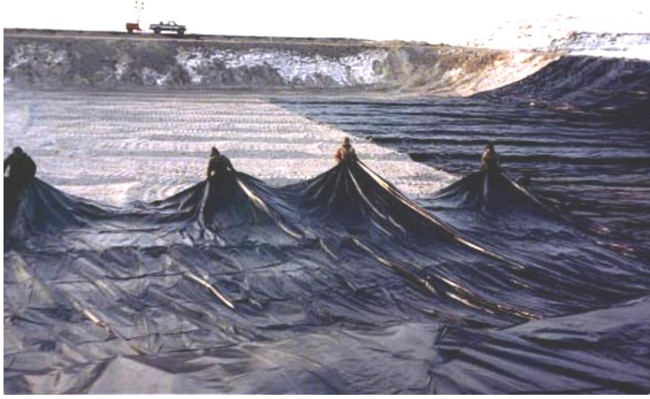
Şekil 1.38. Geomembranın saha uygulaması (URL-7, 2013)
