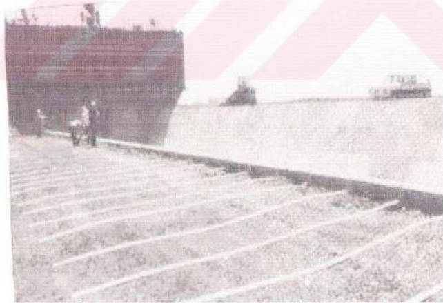
Şekil 2.23: İnşaat esnasında şeritlerin serilmesi(The Reinforced Earth Company kataloğu,1998)
