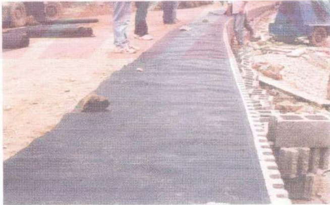
Şekil 2.27: Geotekstil uygulaması (The Reinforced Earth Company kataloğu, 1998)
