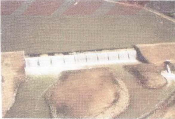
Şekil 2.25: Baraj inşaatında kullanılışı(The Reinforced Earth Company kataloğu, 1998)
