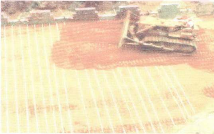
Şekil 2.17: Donatılı zemin inşaatı(Reinforced Earth Company kataloğu, 1998)
