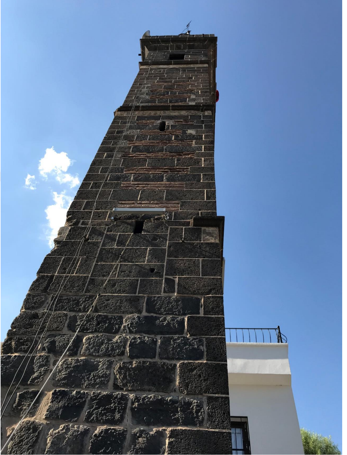
Şekil 4.27. Güney cephesinin fotoğrafı-1.
