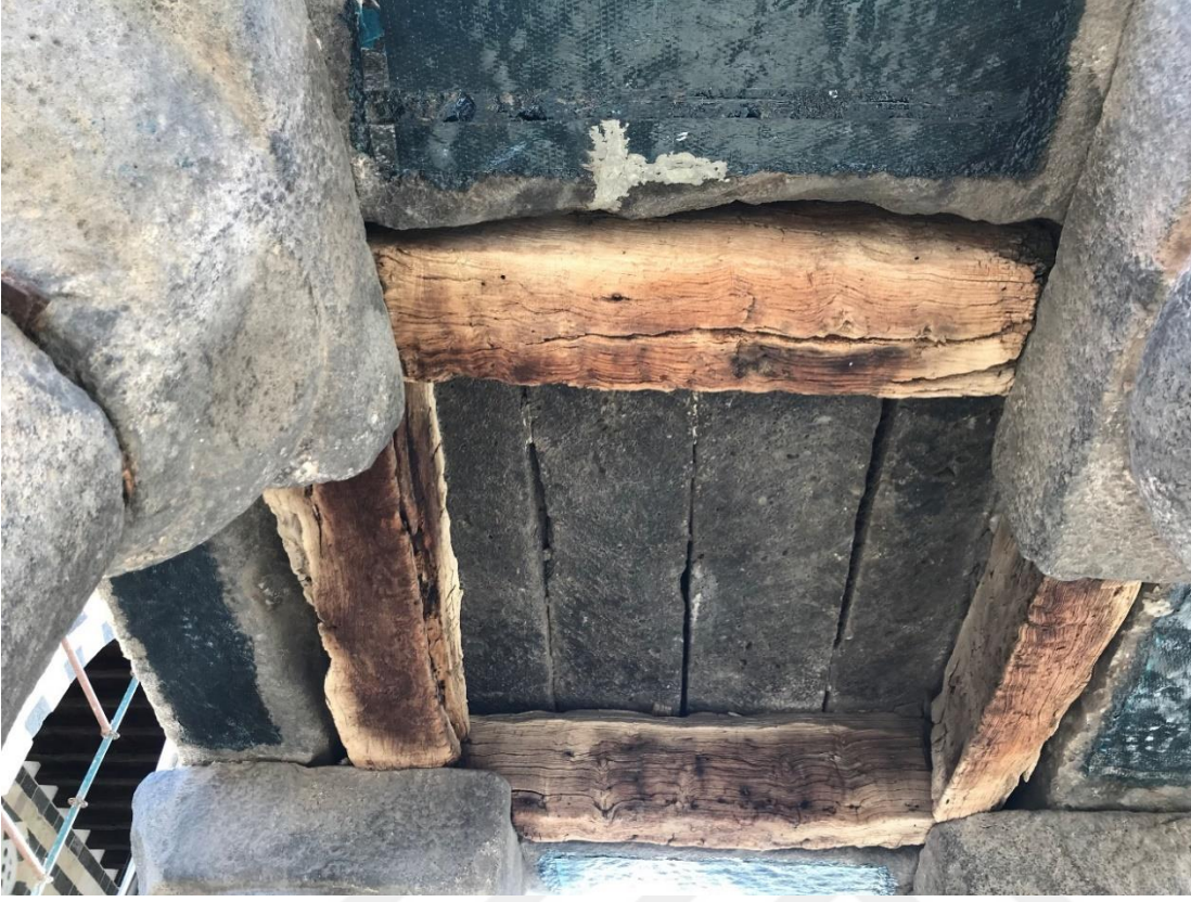
Şekil 4.20. Kirişlerle aynı seviyede bulunan ahşap lentolar.
