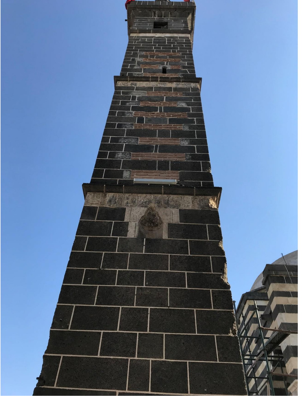
Şekil 4.35. Kuzey cephesinin fotoğrafı-1.
