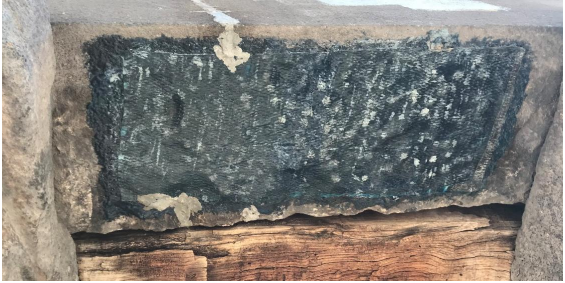
Şekil 4.19. Yapısal çatlak bulunan kirişlerden B4'e FRP bandı ile uygulanan sargı.
