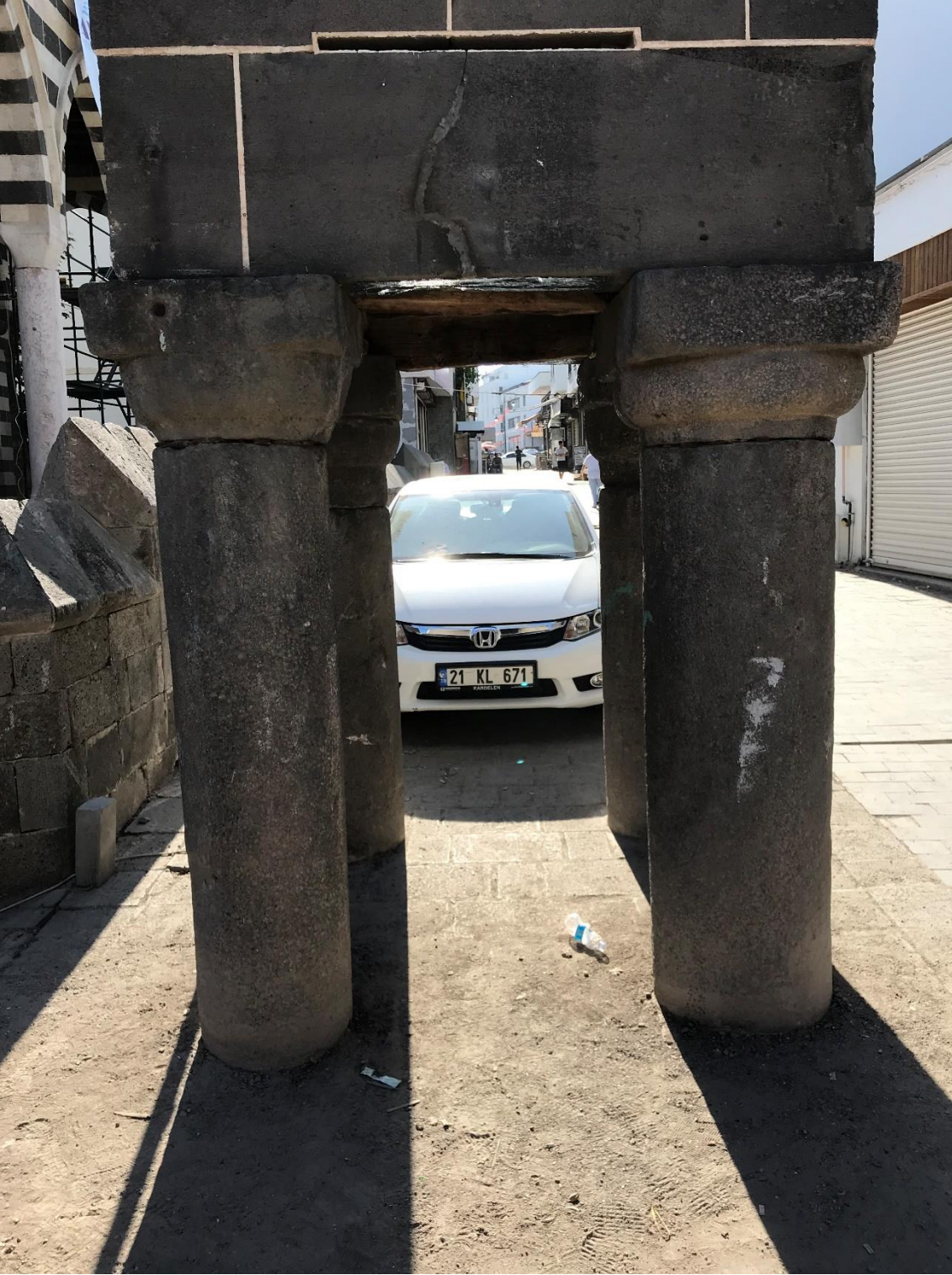
řekil 4.32. Doęu cephesinin fotoęrafı-2.
