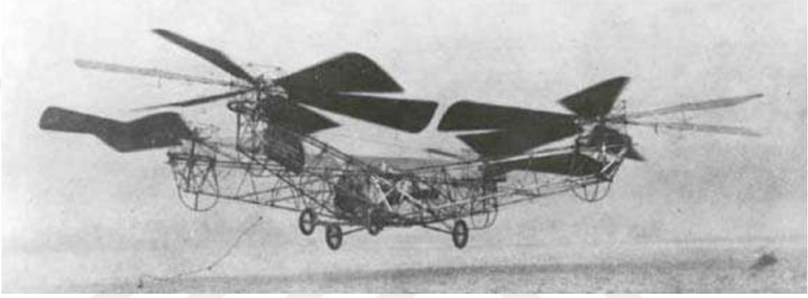
Şekil 1.4. Bothezat tarafından tasarlanan quadrotor (Ali, 2010).
