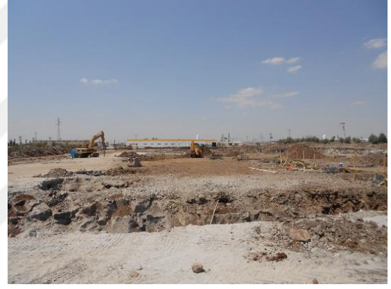
Resim 3.2. Tesis inşaatı kazı işleri
