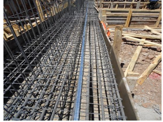
Resim 3.4. Tesis inşaatı alt yapı işleri
