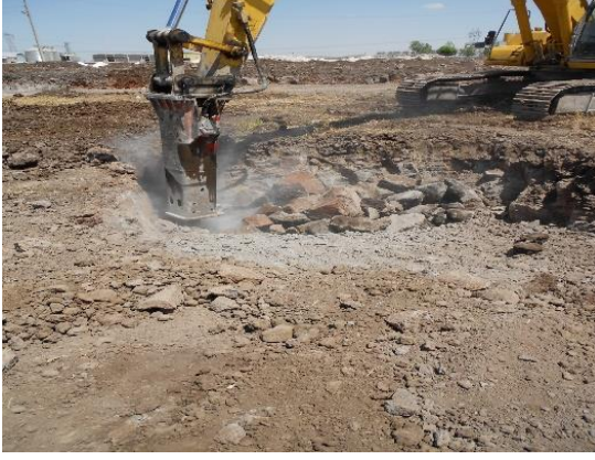
Resim 3.1. Tesis inşaatı kazı işleri
