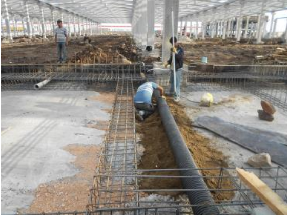
Resim 3.3. Tesis inşaatı alt yapı işleri
