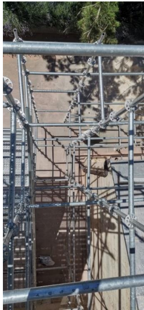
Şekil 1.12. Flanşlı iskele (Mevlana müzesi kubbe-i hadra restorasyonu kuş bakışı görünüm)
