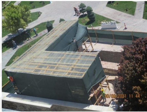
Şekil 1.8. Ahşap takma iskele (Mevlâna Müzesi Eflaki Ahmet Dede Türbesi)
