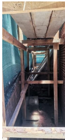
Şekil 1.9. Ahşap takma iskele (Mevlâna Müzesi Eflaki Ahmet Dede Türbesi)
