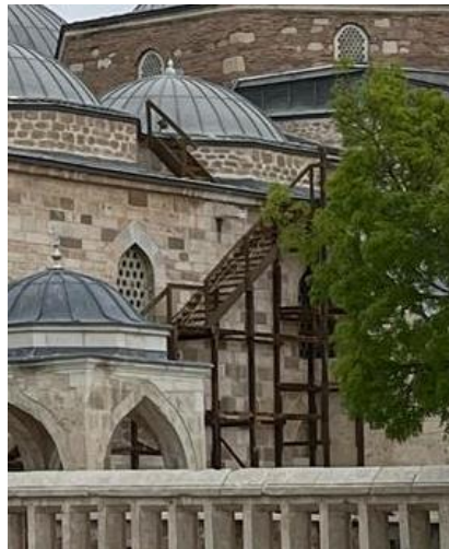
Şekil 1.5. Mevlana müzesi kubbe-i hadra restorasyonu ahşap merdiven iskele son hali
