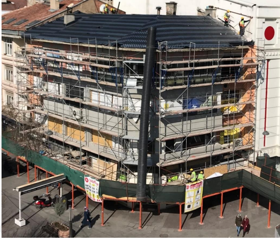
Şekil 1.17. H tipi iskele (Alaaddin bulvarı cephe rehabilitasyonu 2.etap Zafer meydanı kibrit binası)
