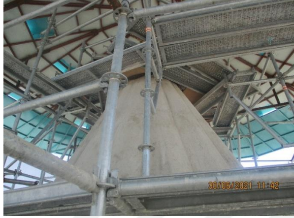
Şekil 1.13. Flanşlı iskele birleşim detayları (Mevlana müzesi kubbe-i hadra restorasyonu külah kısmı)
