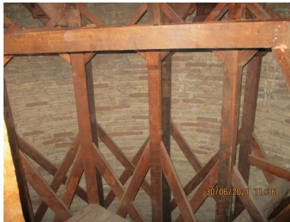
Şekil 1.7. Ahşap seren iskele (Mevlâna müzesi kubbe-i hadra restorasyonu kubbenin iç kısmı)
