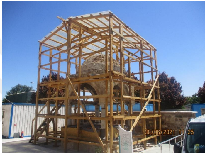
Şekil 1.6. Ahşap seren iskele (Mehmed Bey Türbesi)
