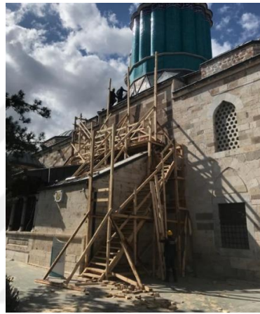
Şekil 1.4. Mevlana müzesi kubbe-i hadra restorasyonu ahşap merdiven iskele kurulum aşaması
