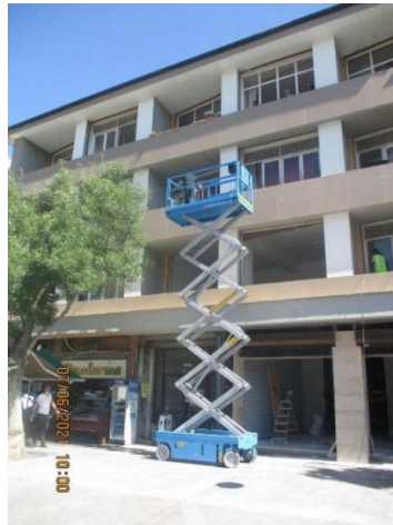
Şekil 1.20. Teleskopik mobil iskele (Alaaddin bulvarı cephe rehabilitasyonu 2.etap)
