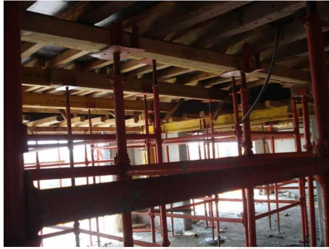
Şekil 1.15. Cuplock (fincan) tipi iskele
