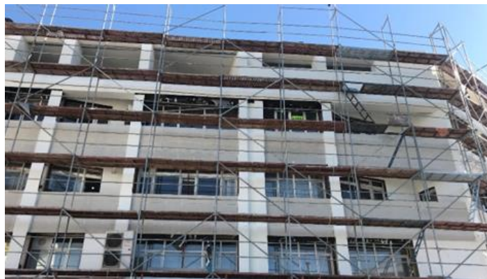
Şekil 1.16. H tipi iskele (Alaaddin bulvarı cephe rehabilitasyonu 2.etap)
