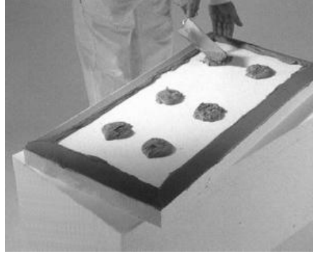
Resim 2.2 Mantolama kompozitlerinde kullanılan yapıştırma harcı.
