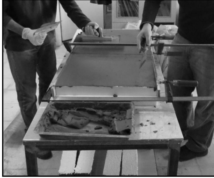
Resim 4.1. Yalıtım levhalarına sıva yapılması.
