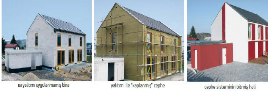
Resim 2.1 Bina dış cephe yüzeyine ETICS uygulamaları.
