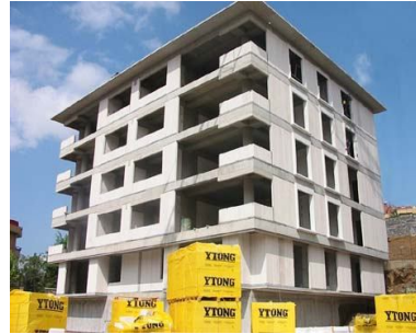
Resim 2.1. Tuğla ve gaz beton bloklarla oluşturulan dış duvarlar
