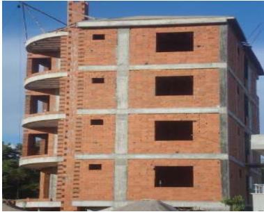
Resim 2.1. Tuğla ve gaz beton bloklarla oluşturulan dış duvarlar
