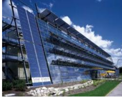
Şekil 4.8 : Hem yarı geçirgen cephe kaplaması, hem de gölgeleme bileşeni olarak kullanılmış FV paneller [82].
