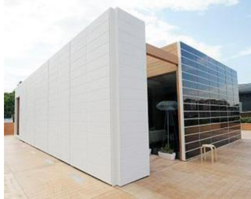
Şekil 4.10 : Yağmur perdeleme sistemine tespit edilmiş fotovoltaiik panellerin şematik gösterimi ve uygulaması [58,84].
