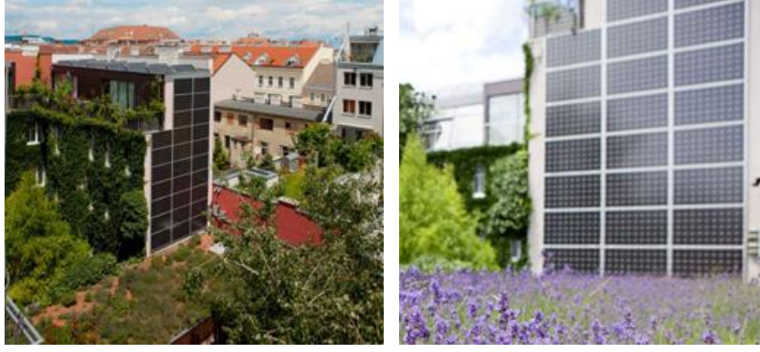
Şekil 4.3 : Viyana Stadthalle Butik Otel dış duvarına tespit edilen FV paneller [77].
