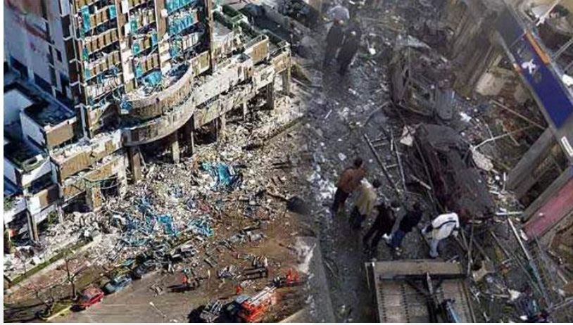
Şekil 3.4. Türkiye'nin İstanbul ilinde HSCB binasında patlama (NTV)
