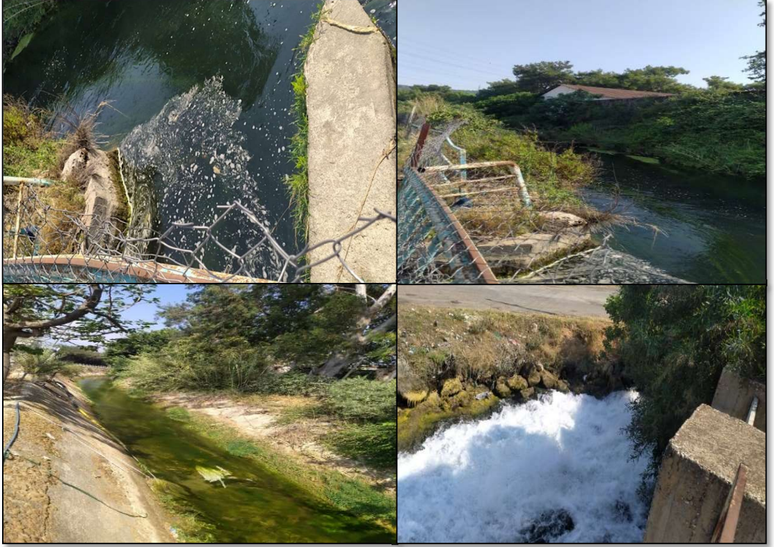
Şekil 3.8. Düden Çayı kanalının geçtiği yerlerden çeşitli görüntüler (Orijinal)
