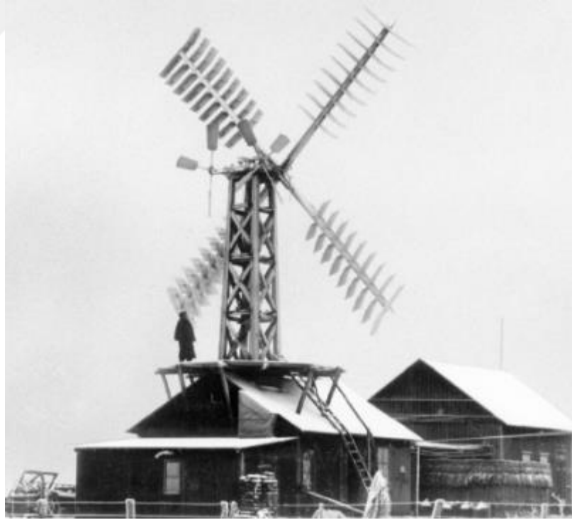
Şekil 3-1: Poul La Cour'un 1891'deki ilk elektrik üreten rüzgar türbini. [a]
