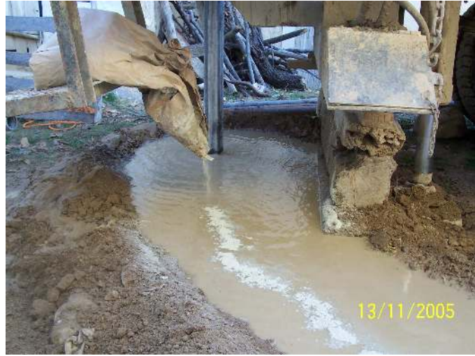
Şekil 3.10. Bentonitin çalışma suyuna eklenmesi
