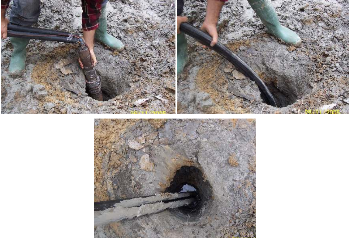
Şekil 3.20. Ucuna ağırlık takılan U-borusunun kuyuya bırakılmasının görüntüleri
