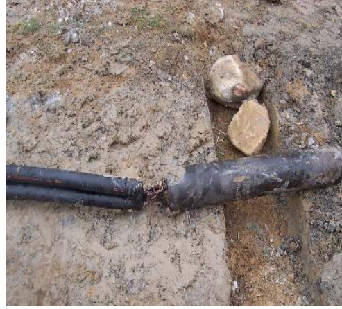
Şekil 3.17. U-borusuna bağlanan ağırlığın görünümü
