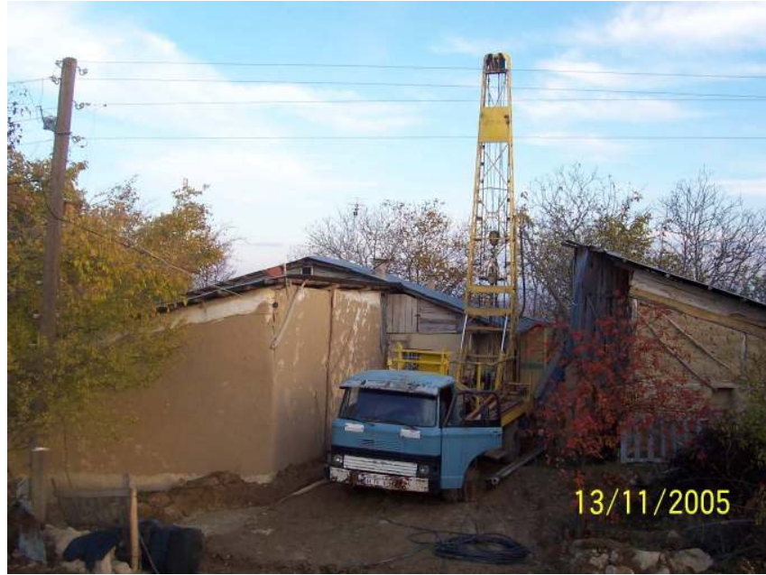
Şekil 3.8. Kazı aracının fotoğrafı
