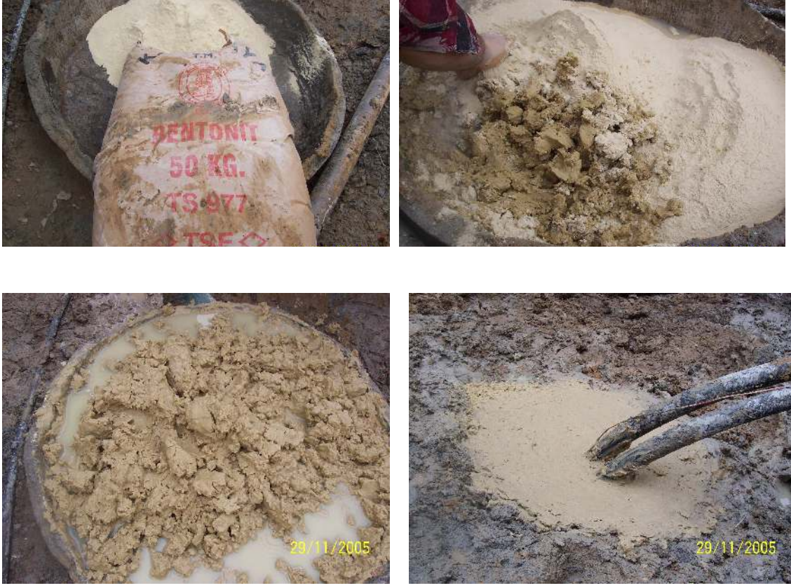
Şekil 3.22. Bentonitin hazırlanışı ve kuyulara doldurulması
