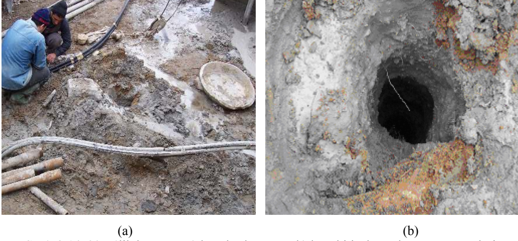
Şekil 3.14. 90 m'lik kuyunun a) kazı başlangıç ve b) kazı bitiş durumlarının görüntüleri
