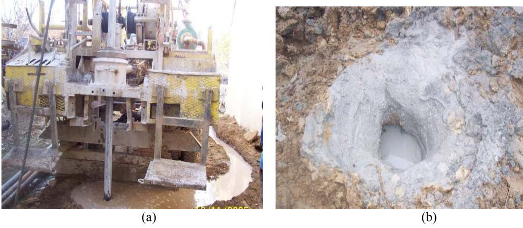
Şekil 3.12. 30 metrelik kuyunun a) kazı başlangıç ve b) kazı bitiş durumlarının görüntüleri
