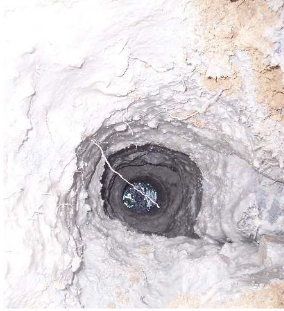
Şekil 3.21. Bentonitin kuyu içerisinde oluşturduğu duvarın görüntüsü
