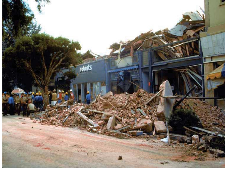
Şekil 2.2. Loma Prieta depremi sonrası görülen hasar örneği
