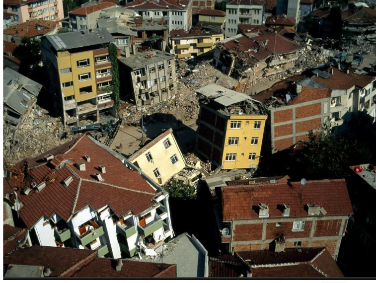
Şekil 2.5. Adapazarı ilinden çarpışma hasarlarına örnek
