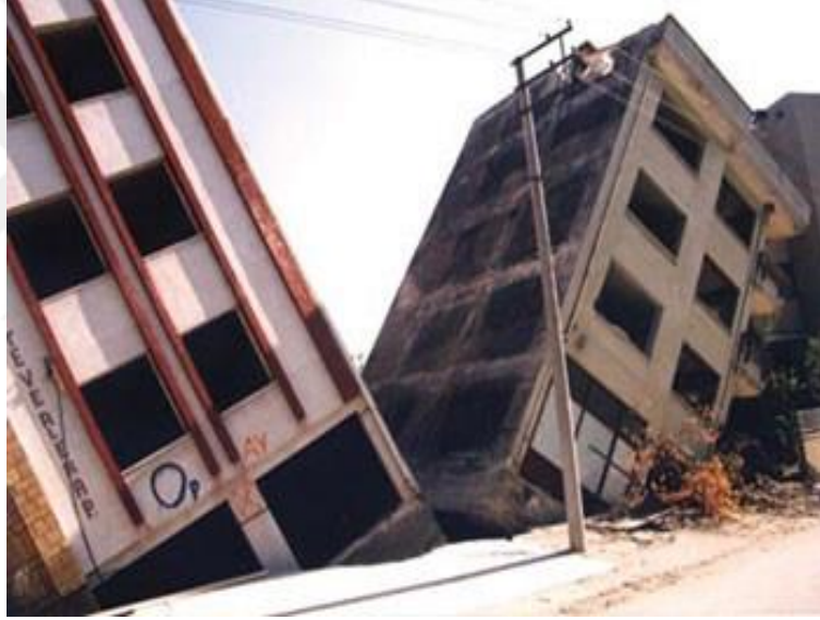
Şekil 2.16. Bir binanın diğer bina üzerine yıkılmasıyla meydana gelen çarpışma
