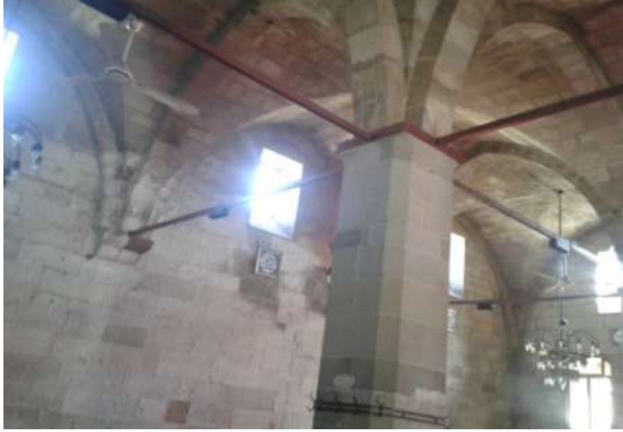
Şekil 1.3: Dikdörtgen bileziklerin herbir kenarının ortasına kaynaklanan gergi çubukları.
