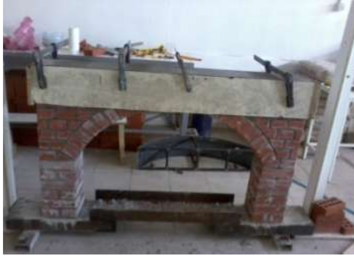
Şekil 3.10: Kemer üzerine beton dökümü.
