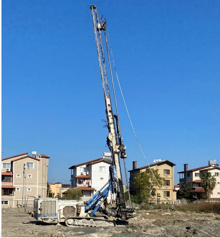
Şekil 7. Jet Grout ile Zemin İyileştirme
