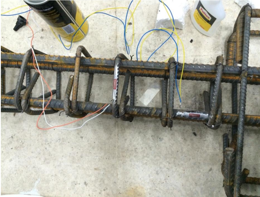
Şekil 3. 41. Donatı yüzeyine şekil değiştirme ölçerlerin yerleştirilmesi
