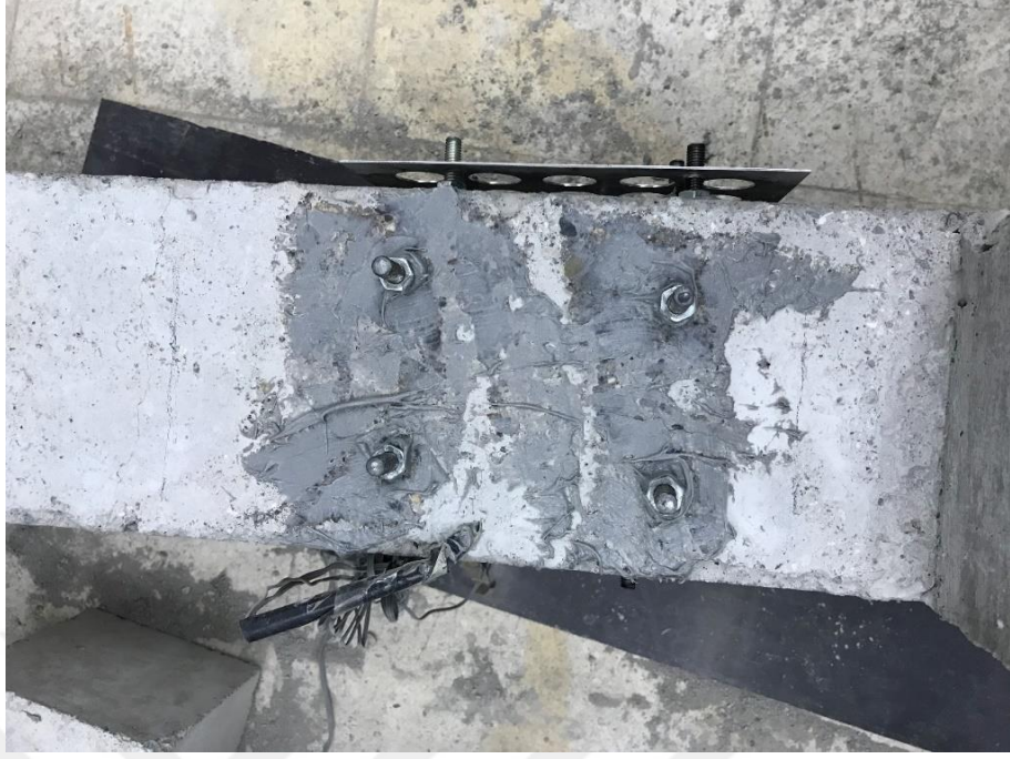
Şekil 3. 29. Ankraj deliklerine 8 mm'lik tijlerin epoksi ile sabitlenmesi
