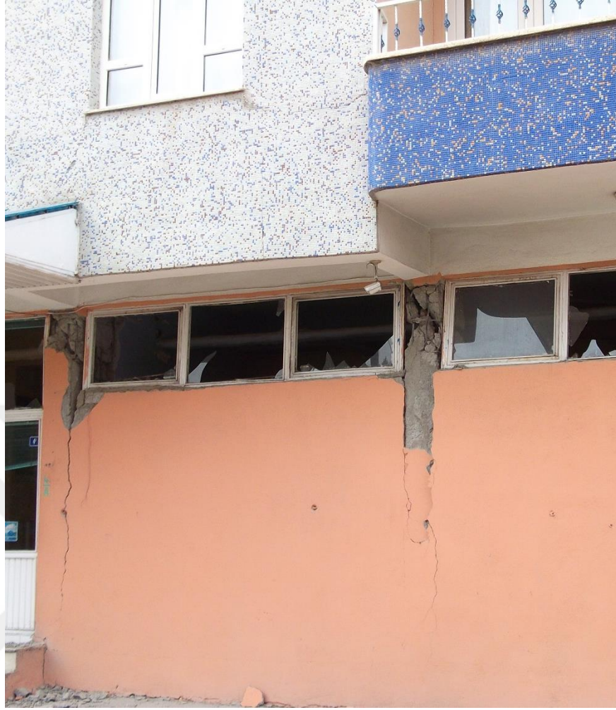
Şekil 1. 2. 2011 Van depremi kısa kolon kesme hasarı (Doç. Dr. İdris Bedirhanoğlu'nun arşivinden alınmıştır.)
