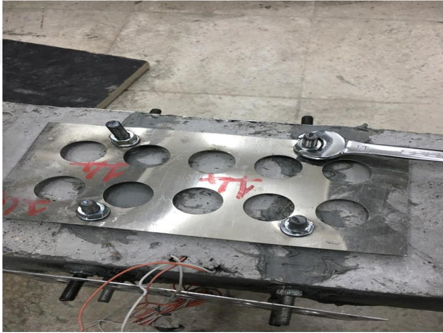
Şekil 3. 30. Güçlendirme çelik plakaların tijlere sabitlenmesi
