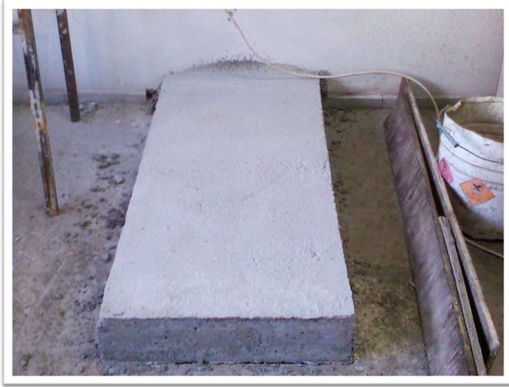
Resim 8.4. Temel betonunun bir görünüşü [27]
