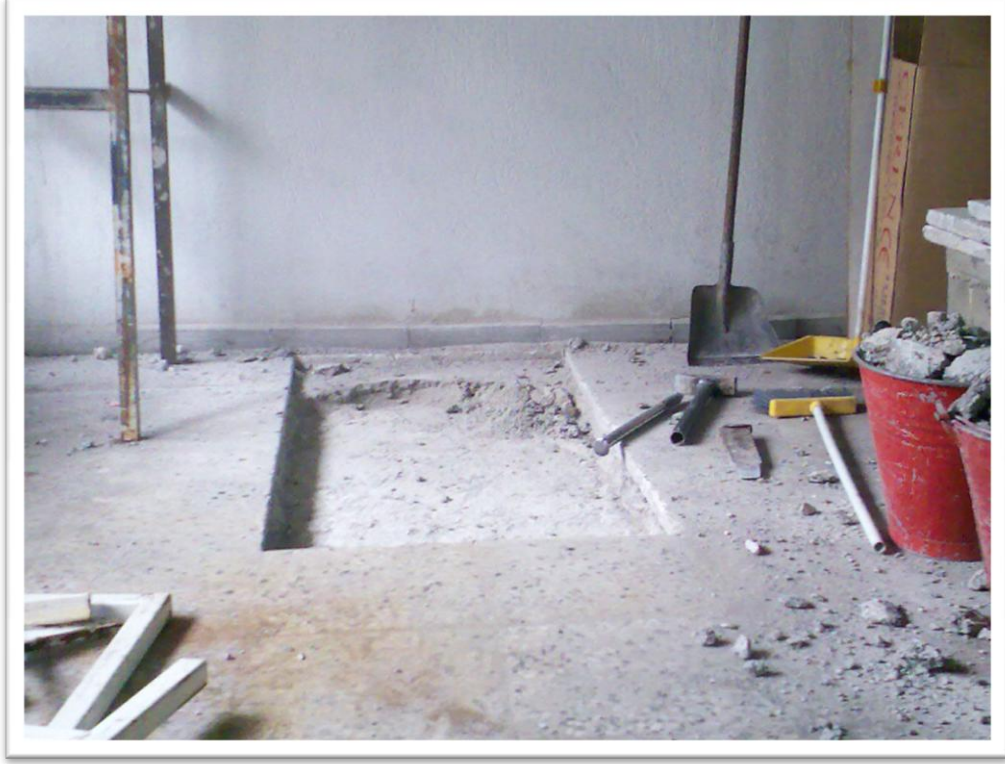
Resim 8.3. Temel betonunun atılacağı yer [27]
