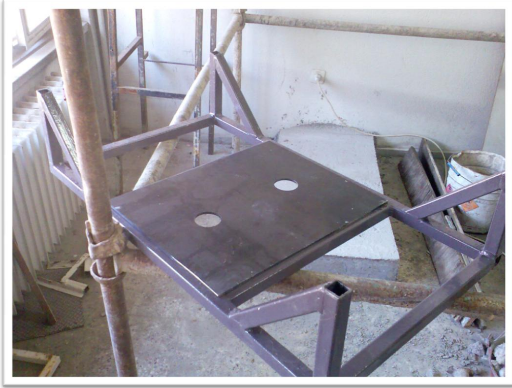
Resim 8.5. Taşıyıcı iskeletin bir görünüşü [27]
