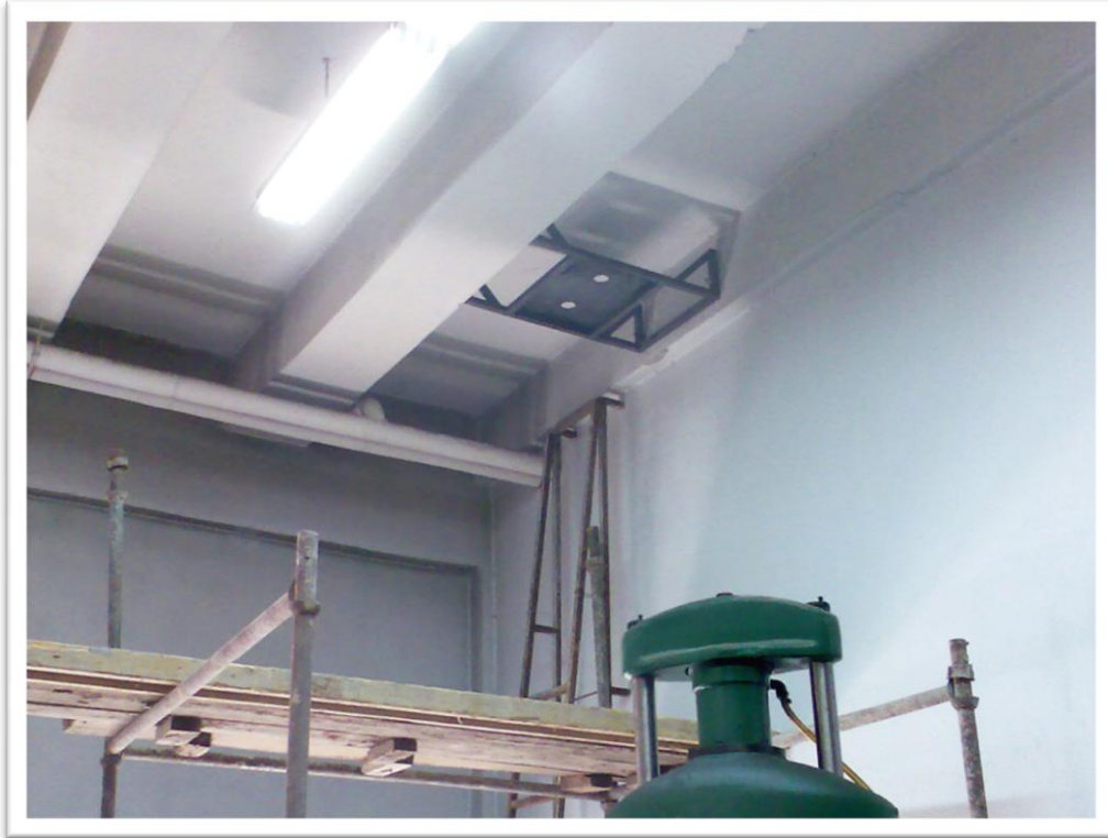
Resim 8.6. Taşıyıcı iskeletin asıldıktan sonraki görünüşü [27]
