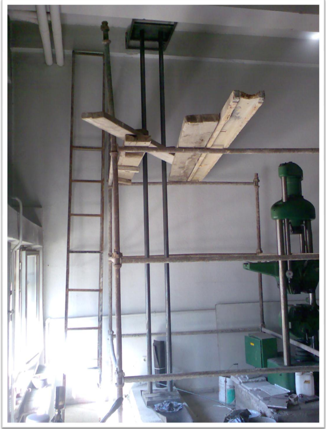
Resim 8.7. Kızak boruları asıldıktan sonra düzeneğin bir görünüşü [27]
