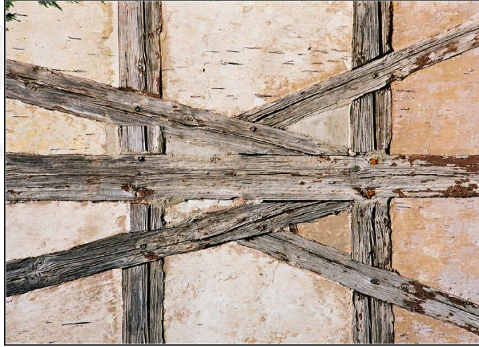
Şekil 1.3 Olszyna köyünde bulunan bir kilise duvarı (Trekearth, 2005)
