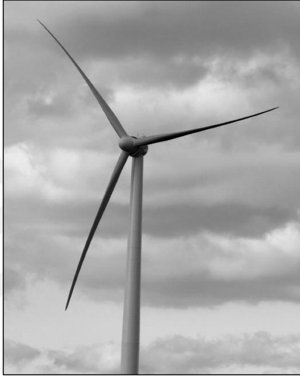
Şekil 1.1 Cam elyaf-epoksi matrisli kompozitlerden yapılmış rüzgâr gülü (Stokke, Wu ve Han, 2013)
