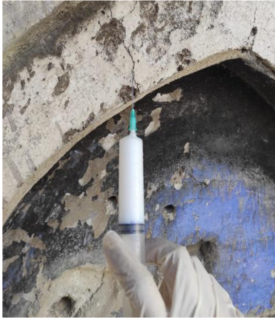
řekil 2.8 Hacı Bayram Veli Cami ev hamamı, 18. yy saęlamlařtırma çalıřması (Hayrunnisa Ünal Fotoęraf Arřivi)
