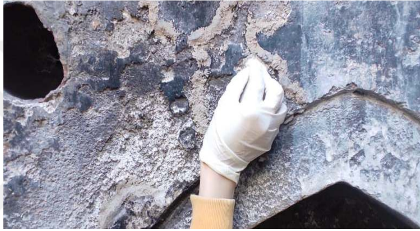
Şekil 2.9 Hacı Bayram Veli Cami ev hamamı, 18.yy dolgu çalışması (Hayrunnisa Ünal Fotoğraf Arşivi)
