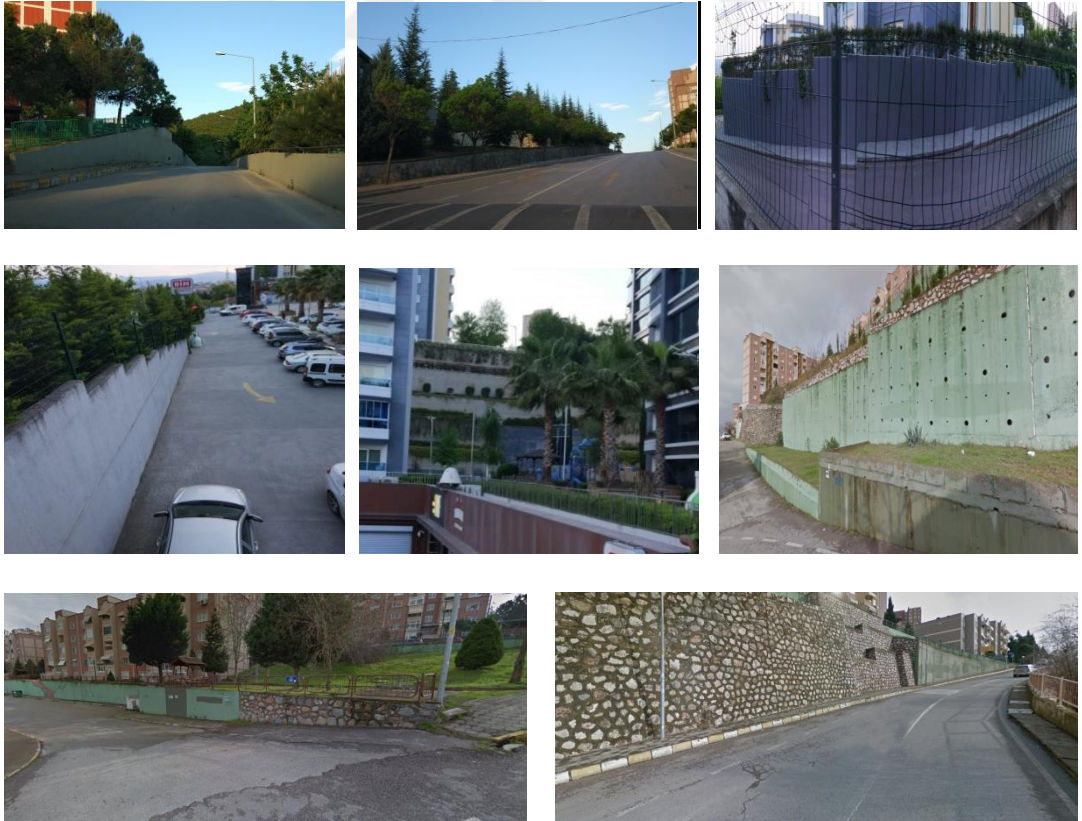
Şekil 4.12. Alikahya Cumhuriyet Mahallesi’ndeki duvarlardan örnekler
