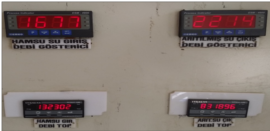
Şekil 2.12. Arıtma tesisi anlık debi panosu verileri.
