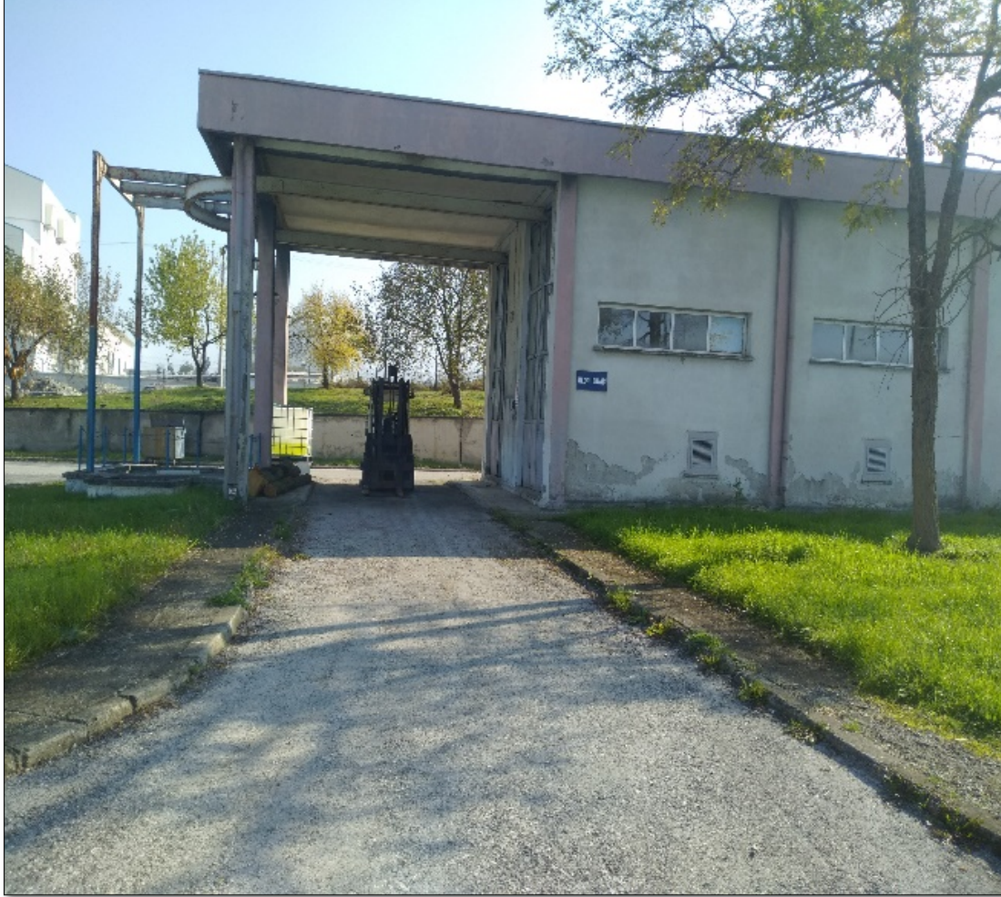
Şekil 2.15. Arıtma tesisi kimyasal depolar bölümü.
