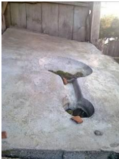
Resim 3.32. Z03 Beton helâ taşı
