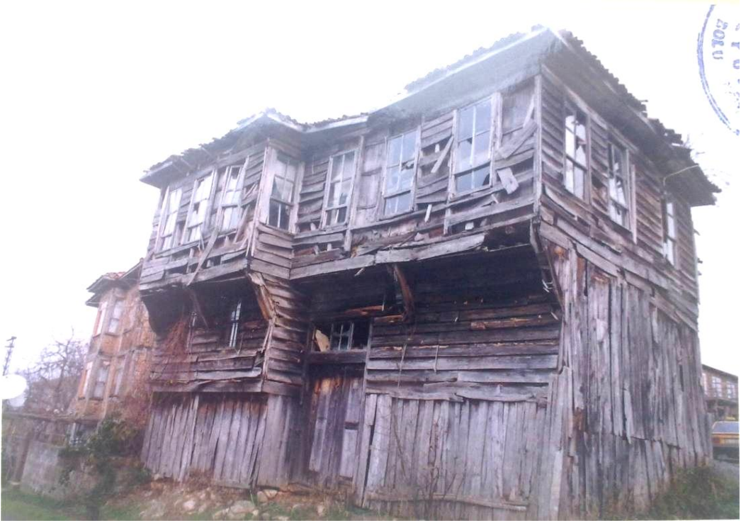
Resim 5.1. Batı Cephesi Fotoğrafi [AKTVKK, 1996]
