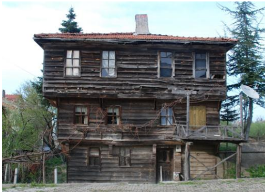
Resim 4.36. Güney Cephesi (Env. 78)
