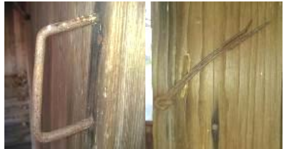
Resim 3.102. Kanca Yuvası ve Kanca Detayı
