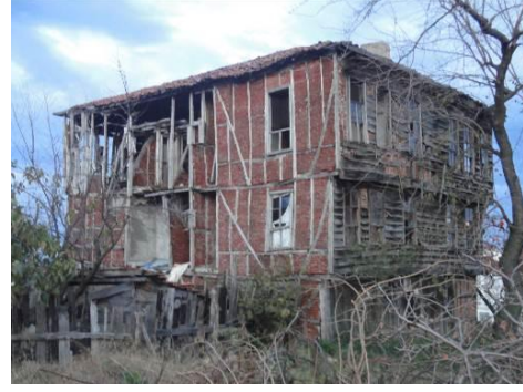
Resim 4.22. Kuzey ve Batı Cephesi
