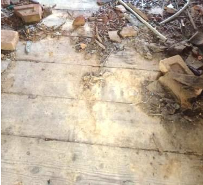
Resim 3.109. Z06 Döşeme Kaplaması
