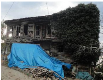
Resim 4.1. Doğu Cephesi (Env. 32)
