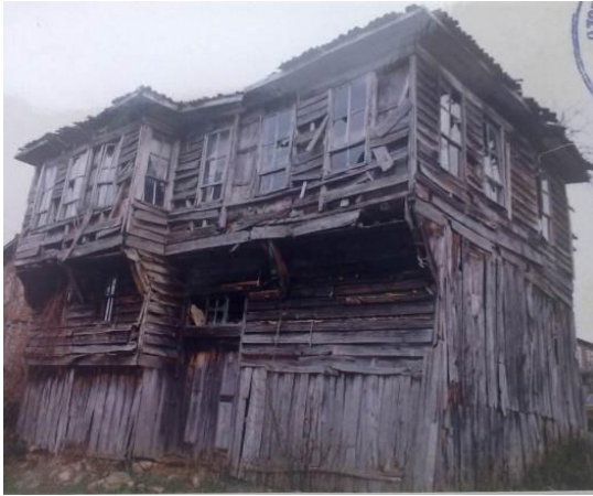
Resim 3.97. Cephede Ahşap Kaplama [AKTVKK, 1996]
