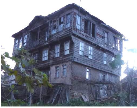
Resim 4.21. Güney ve Doğu Cephesi
