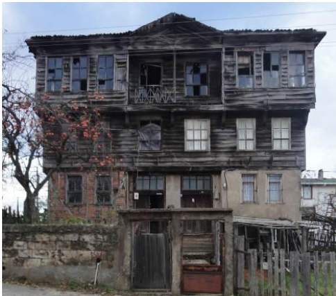
Resim 4.19. Güney Cephesi (Env. 23)
