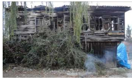
Resim 4.2. Güney Cephesi (Env. 32)
