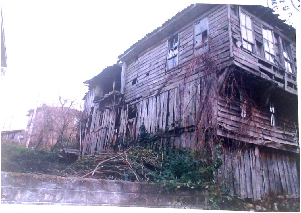
Resim 5.7. Kuzey Cephesi Fotoğrafi [AKTVKK, 1996]
