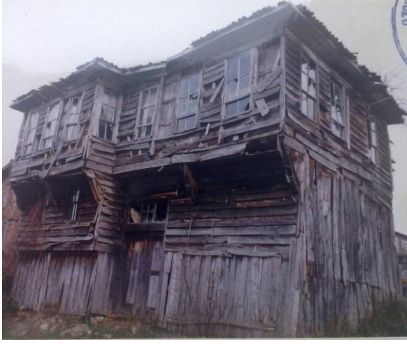
Resim 3.103. Batı ve Güney Cephesi Pencereleri [AKTVKK, 1996]
