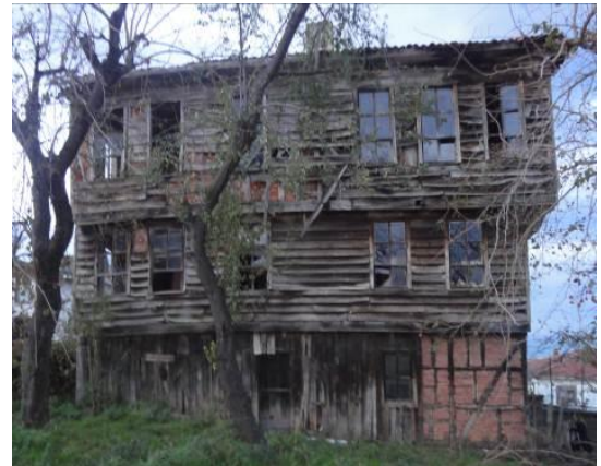
Resim 4.20. Batı Cephesi (Env. 23)
