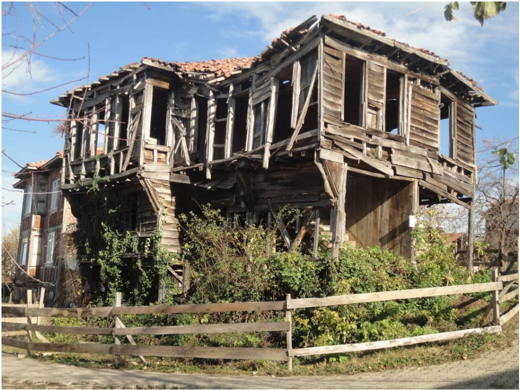
Resim 5.2. Batı Cephesi Fotoğrafi (07.12.2012)
