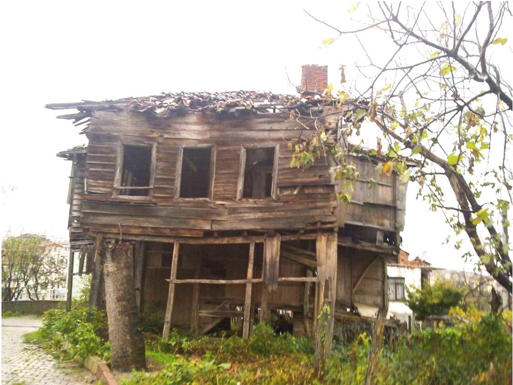
Resim 5.6. Doğu Cephesi Fotoğrafi (07.12.2012)
