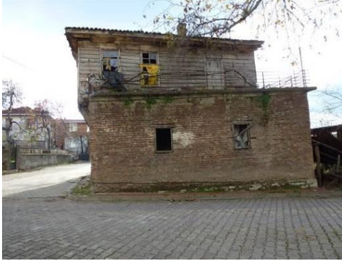
Resim 4.31. Doğu Cephesi (Env. 34)
