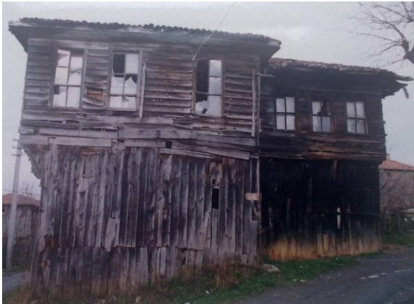
Resim 3.104. Güney Cephesi Pencereleri [AKTVKK, 1996]
