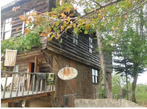
Resim 4.38. Doğu ve Güney Cephesi
