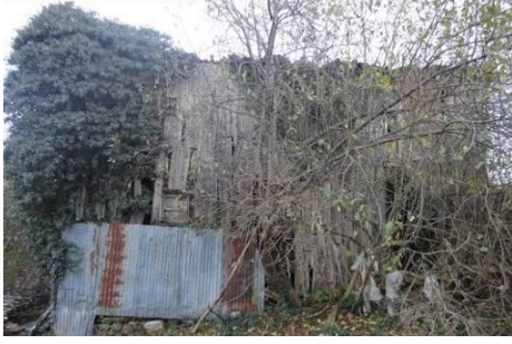
Resim 4.3. Batı Cephesi (Env. No: 32)
