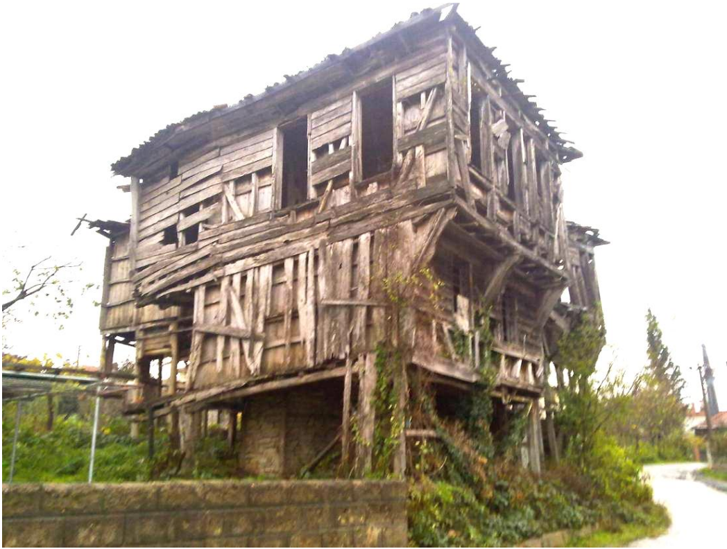
Resim 5.8. Kuzey Cephesi Fotoğrafi (07.12.2012)
