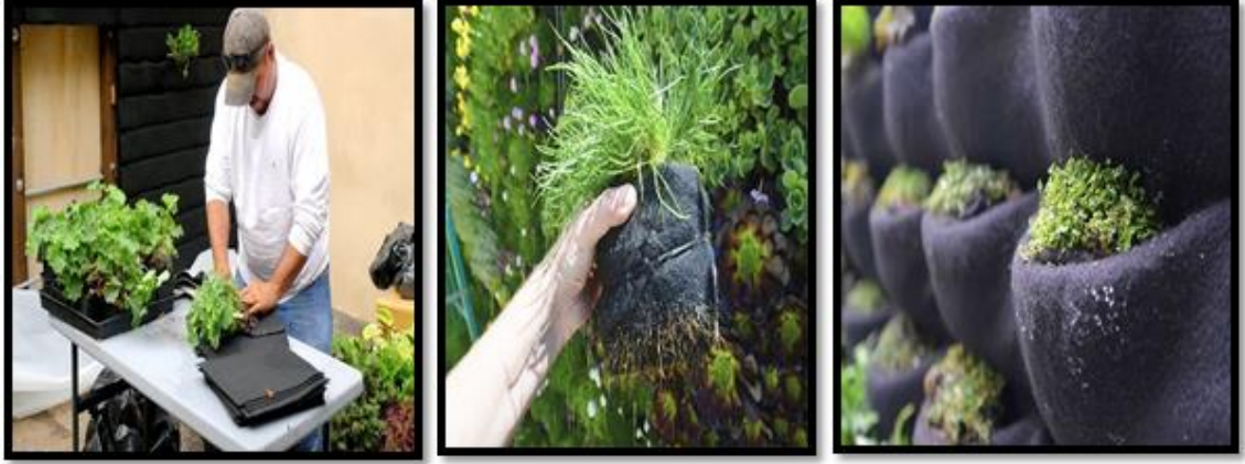
Şekil 1.17. Keçe yüzeyli sistem uygulaması örneği (Anonim, 2020i).
