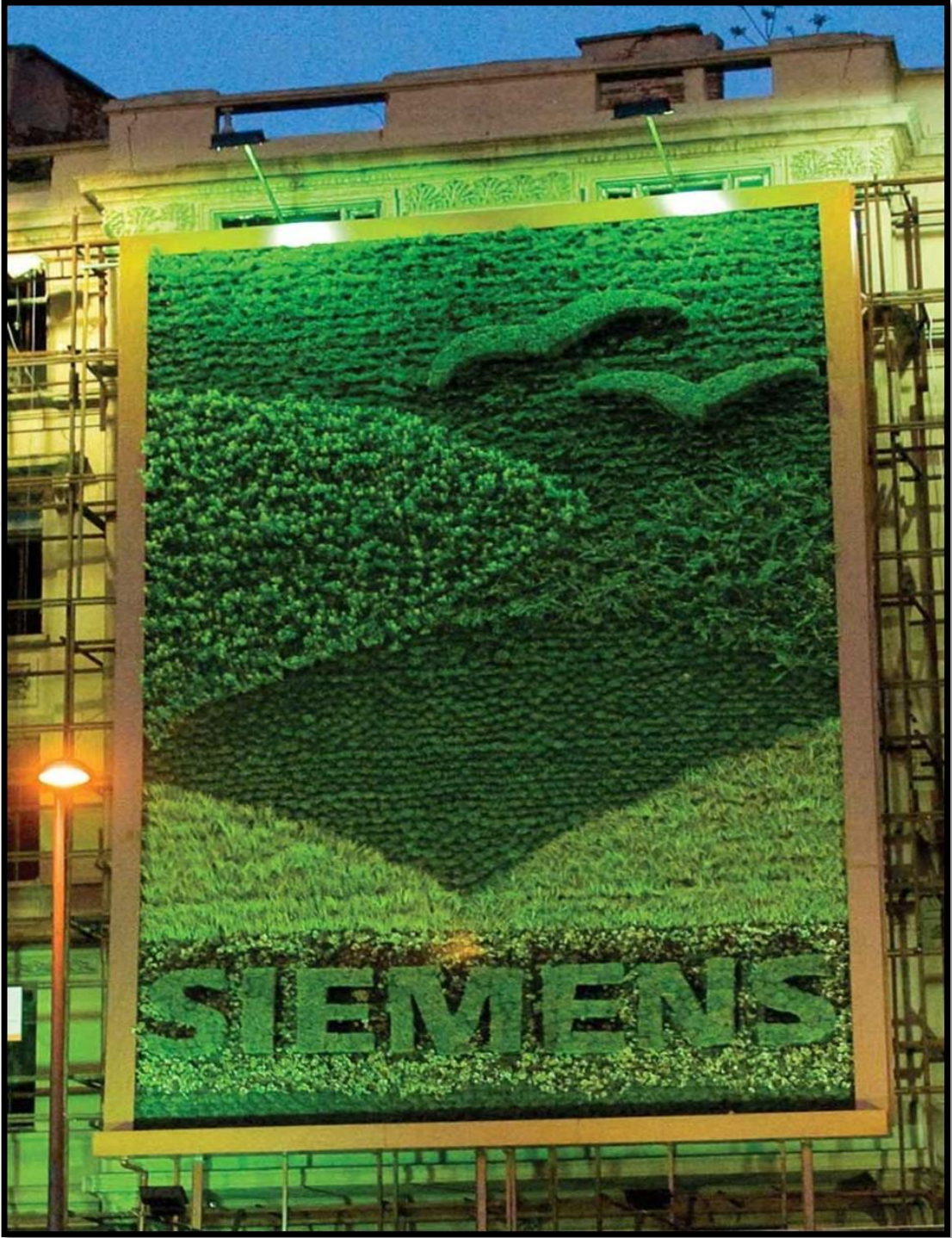
Şekil 1.33. Dış mekan dikey bahçede aydınlatma örneği (Anonim, 2020r).
