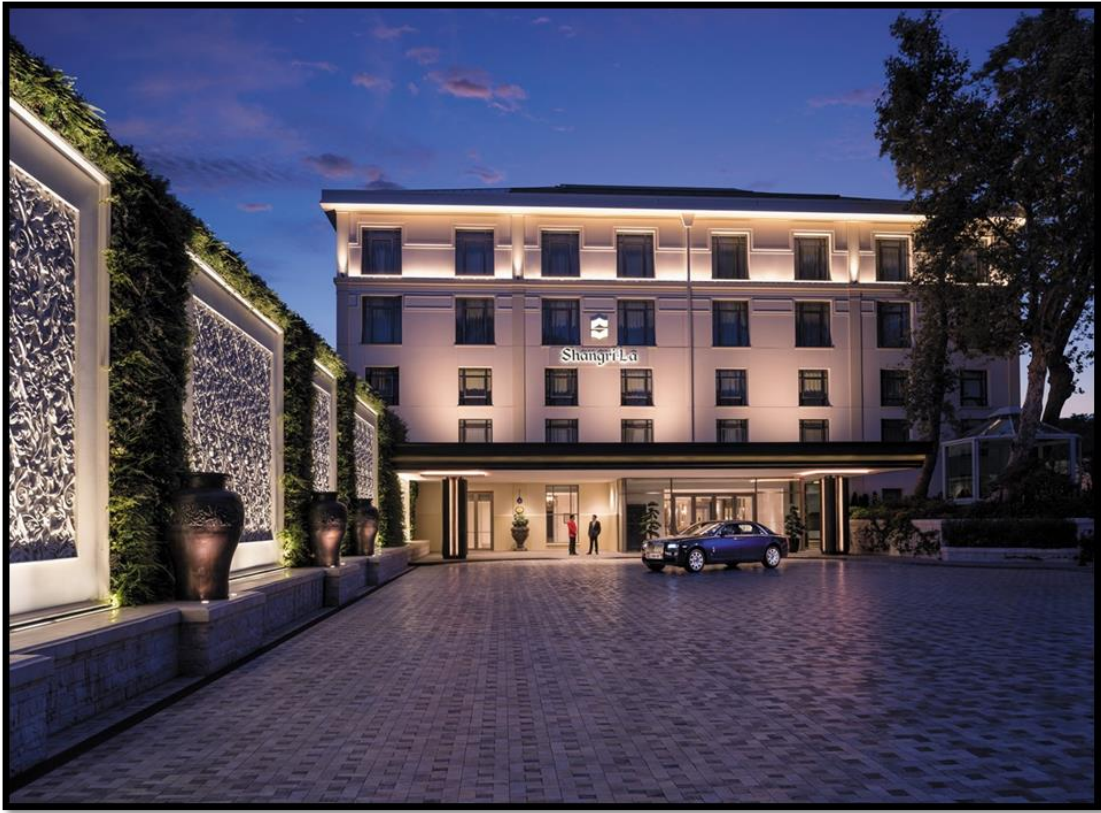
Şekil 1.41. Shangri-La Otel Dikey Bahçe Uygulaması-İstanbul Beşiktaş (Anonim, 2020v).
