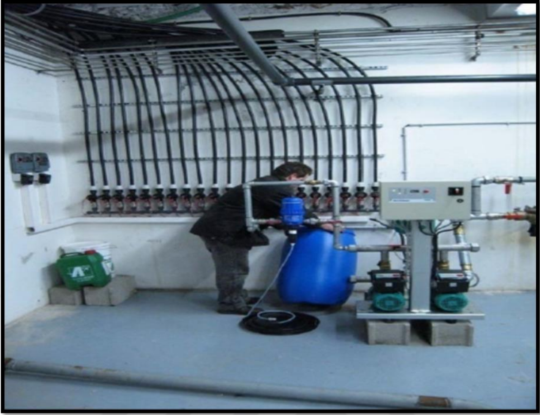
Şekil 1.39. Dikey bahçeler otomatik sulama ve gübreleme sistemlerinin, sisleme sisteminin bakımı (Blanc, 2010).
