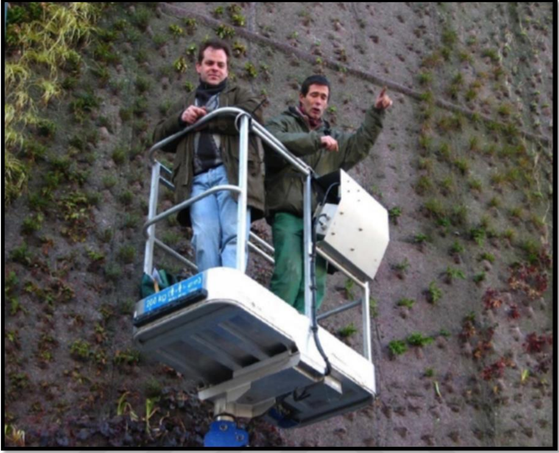
Şekil 1.40. Dikey bahçelerde bitkilerin adaptasyon sürecinin gözlenmesi ve büyüme ortamını oluşturan jeotekstil keçe örtüsünün nem kontrolü (Blanc, 2010).
