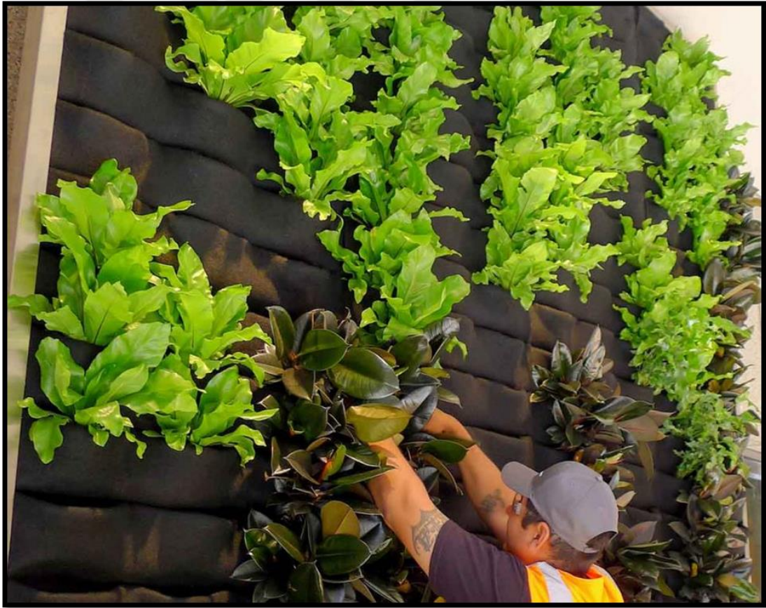
Şekil 1.18. Keçe yüzeyli sistem uygulamasıyla dikey bahçe örneği (Anonim, 2020i).
