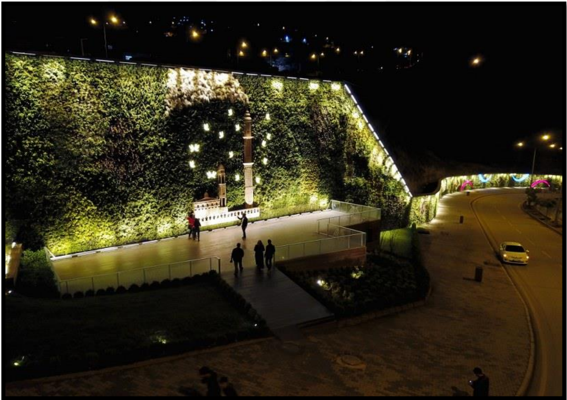
Şekil 1.72. Hava Radar Mevzi Komutanlığı Yokuşu Yeni Hali – Mardin (Anonim, 2020ar).
