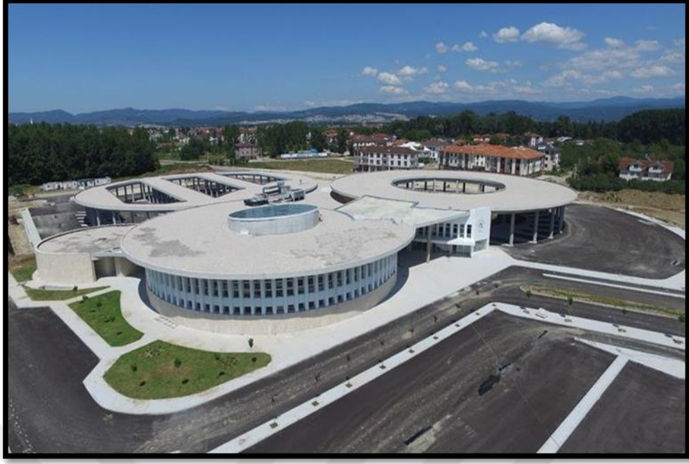
Şekil 2.5. Düzce Şehirler Arası Otobüs Terminali (Anonim, 2020bc).
