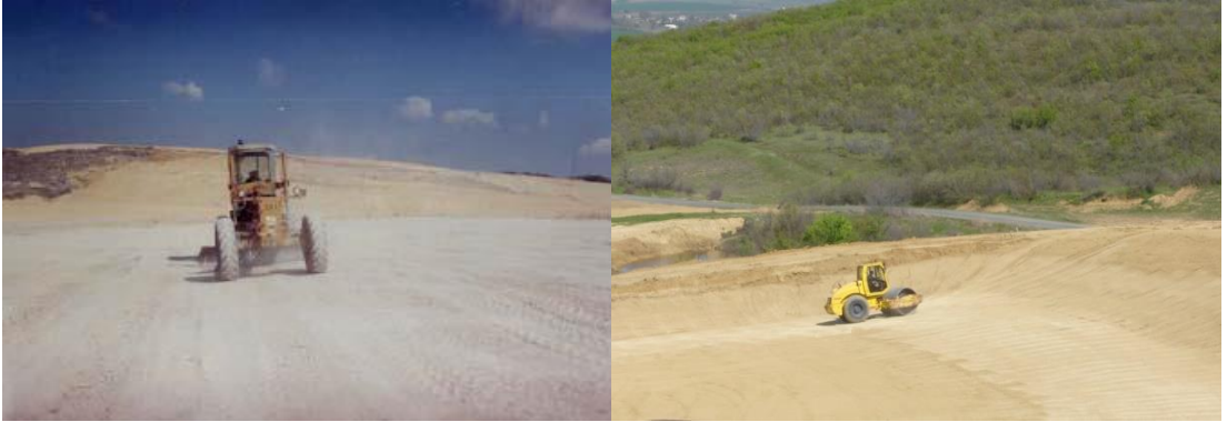
Şekil 2.7. Kil serilmesi ve sıkıştırılması.
