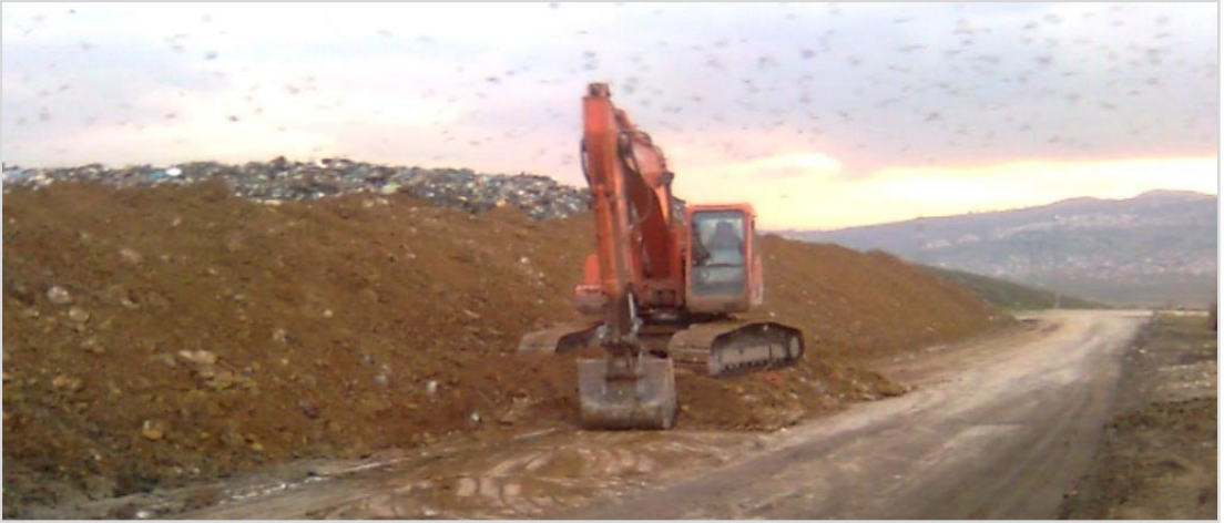
Şekil 2.20. Şev düzenlmesi/örtü toprağı.
