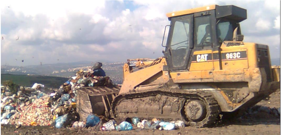
Şekil 2.18. Atıkların serilmesi.
