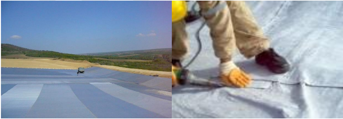
Şekil 2.10. Jeotekstil serilmesi.
