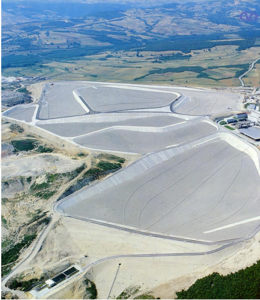
Şekil 3.1. Kocaeli Solaklar katı atık depolama sahası.
