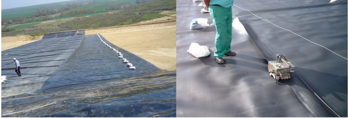
Şekil 2.8. Jeomembran serilmesi.
