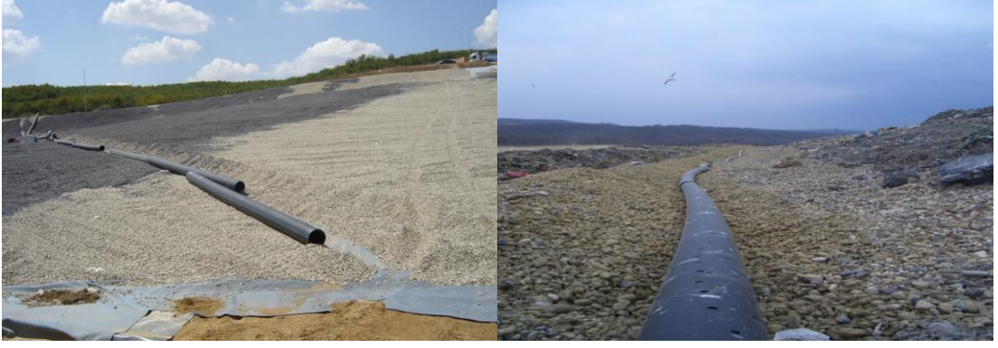
Şekil 2.11. Sızıntı suyu boru yerleştirilmesi ve drenaj malzemesi serilmesi.
