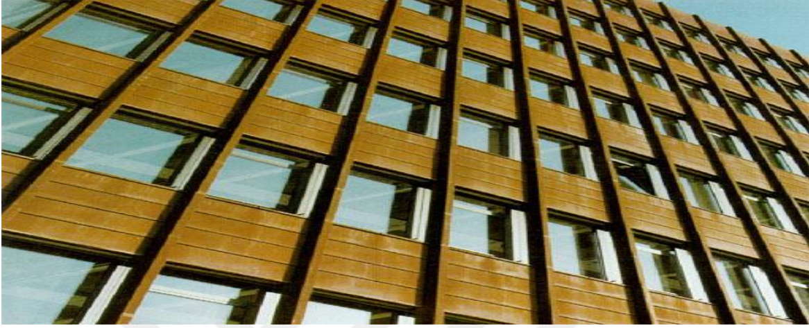
Şekil 1.4. Almanya'nın Karlsruhe şehrinde bulunan Çevre Enstitüsü Binası (Wardenier vd., 2002)
