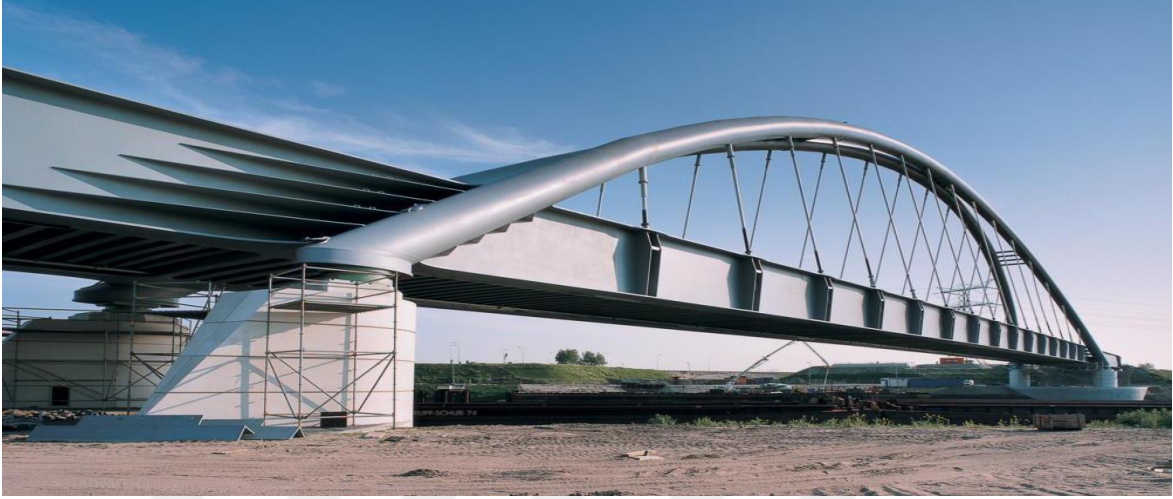
Şekil 1.6. Hollanda’nın Rotterdam kentinde bulunan demiryolu köprüsü (Wardenier vd., 2002)
