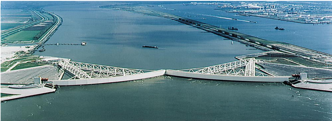
Şekil 1.7. Hollanda’nın Hook kasabası yakınlarında bulunan fırtına kabarması bariyeri (Wardenier vd., 2002)
