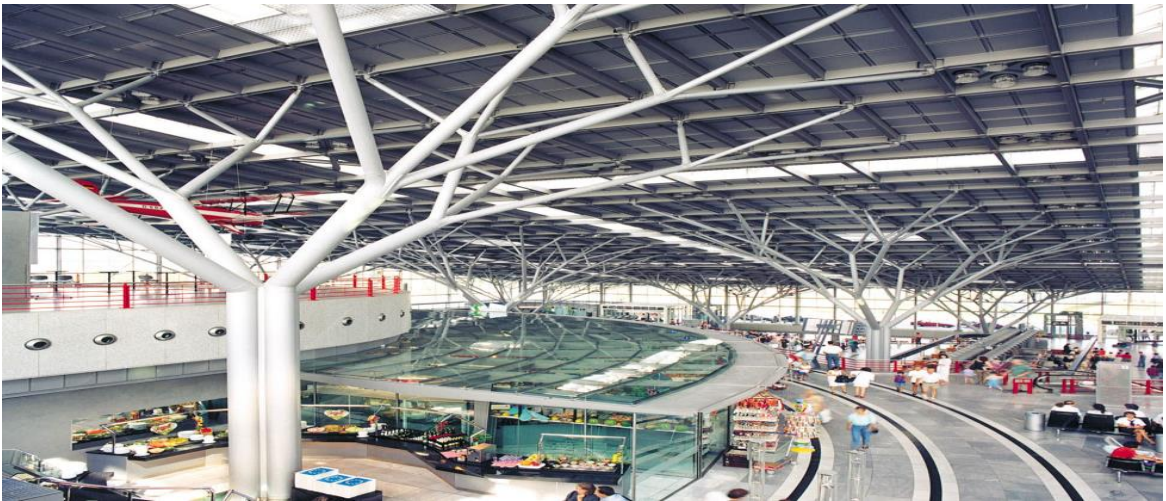
Şekil 1.5. Almanya'da bulunan Stuttgart Havalimanının kalkış bekleme salonu (Wardenier vd., 2002)
