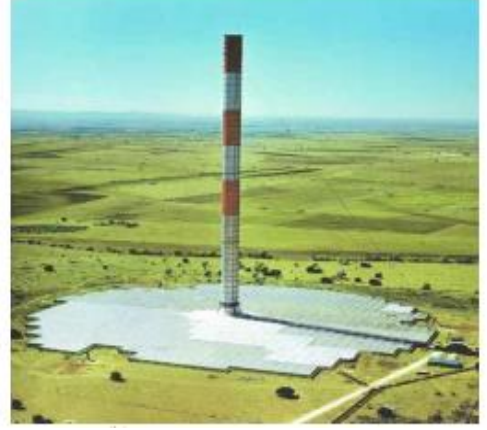
Şekil 1. 28 Güneş bacası şematik gösterimi (Koonsrisuk, 2013)
