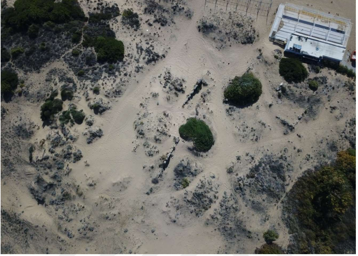
Lev. 26a: Doğu yapısı hava görüntüsü
