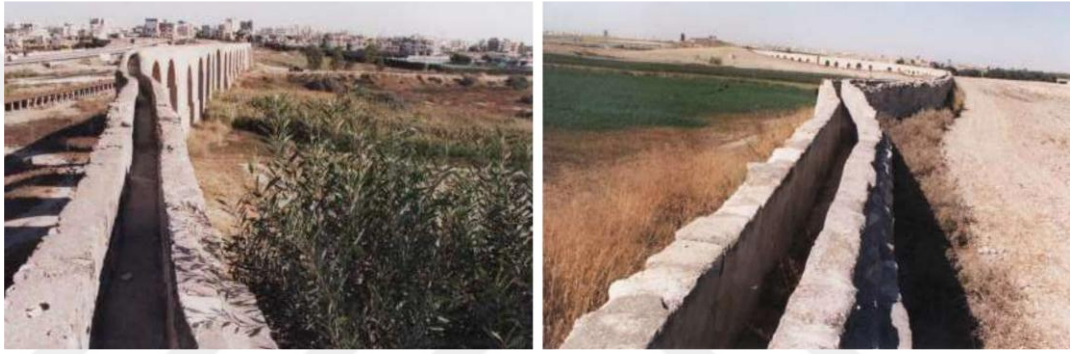
Fotoğraf 6. Su kemerinin birinci ve üçüncü sıra kemerleri üzerinden su taşıyan açık kanallar
