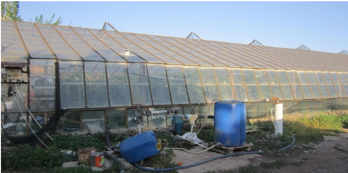
Fotoğraf 1.5 Hasyurt Mahallesi'nde Tarımda Sulama Suyu Temin Etmek Amacıyla Kurulmuş Sondajdan Bir Görünüm
