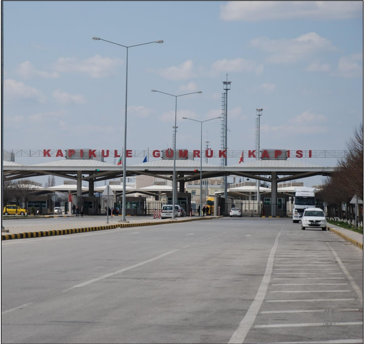
Foto 19. Kapıkule Gümrük Kapısı
