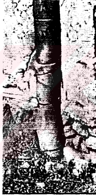
Fotoğraf 131 : Küngün Baca ve Su Oluğu Olarak Kullanımı
