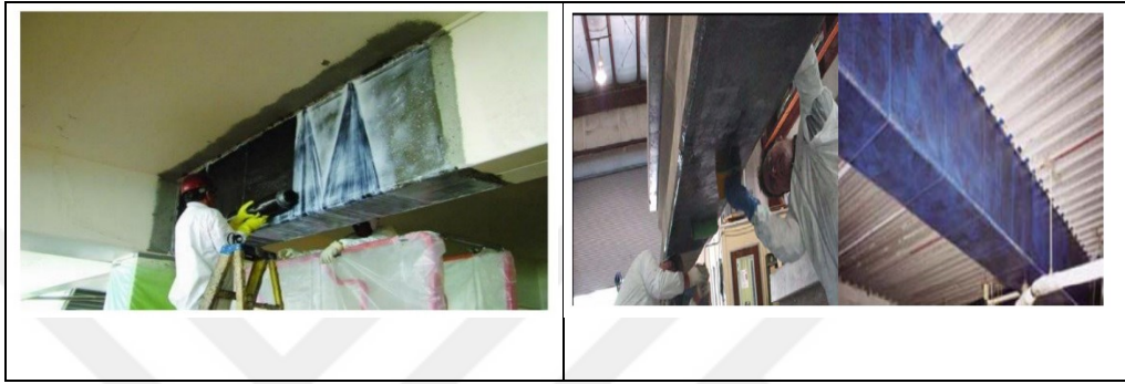
Şekil 2.10. FRP malzemenin kirişlerde uygulanması
