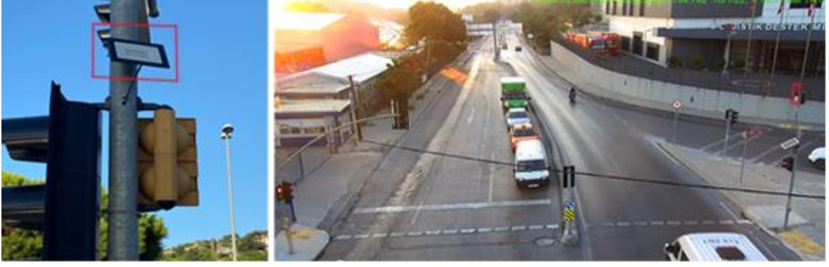
Şekil 28. Direklere montajı yapılan projektörler (solda) ve sarı ışık tahmini yapılan yaya üniteleri (sağda)
