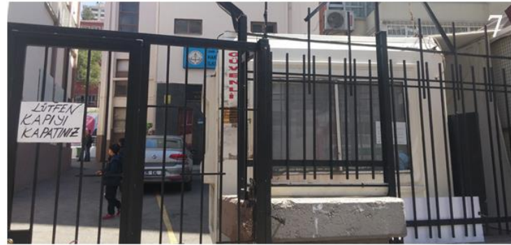
Şekil 3.17 D1 kodlu okul alanı fotoğrafları (C) 1-2. Okul Girişleri, 3-4. Merdiven örnekleri, 5. Otopark Alanı, 6. Sınır Elemanı, 7. Kontrol Kulübesi (Kişisel arşiv, 2017)
