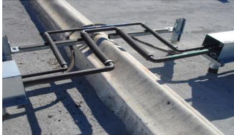
Şekil 4.3. Dilatasyon derzinde uygulanan esnek bağlantının örnek detayı (FEMA, 2012).
