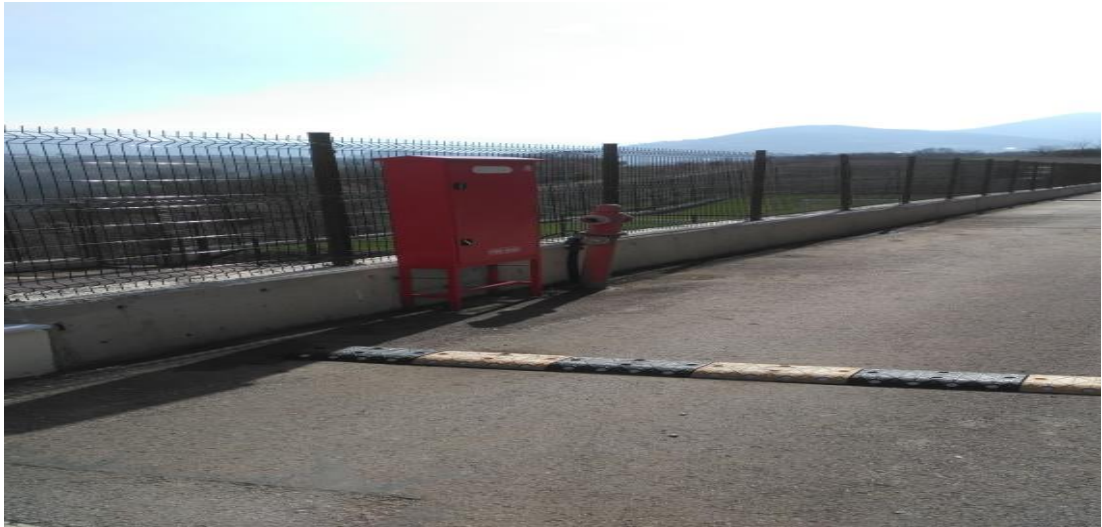
Şekil 5.9. Hidrant
